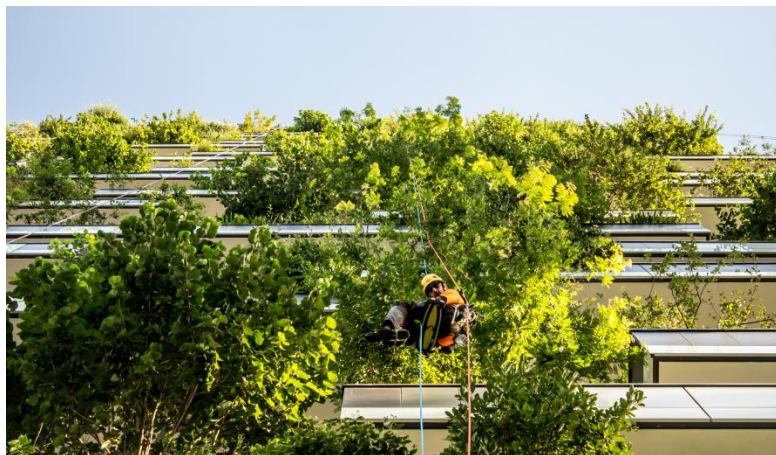
Figura 48: Fotografia Manutenção dos Jardins verticais
