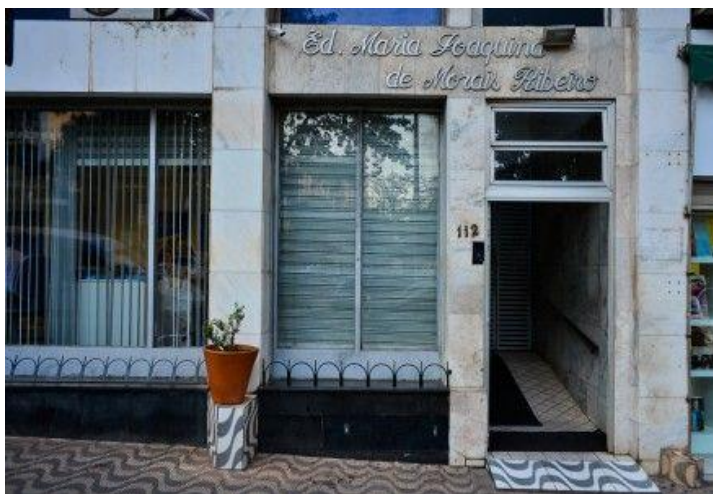
Figura 5: Condomínio Maria Joaquina - Frente
