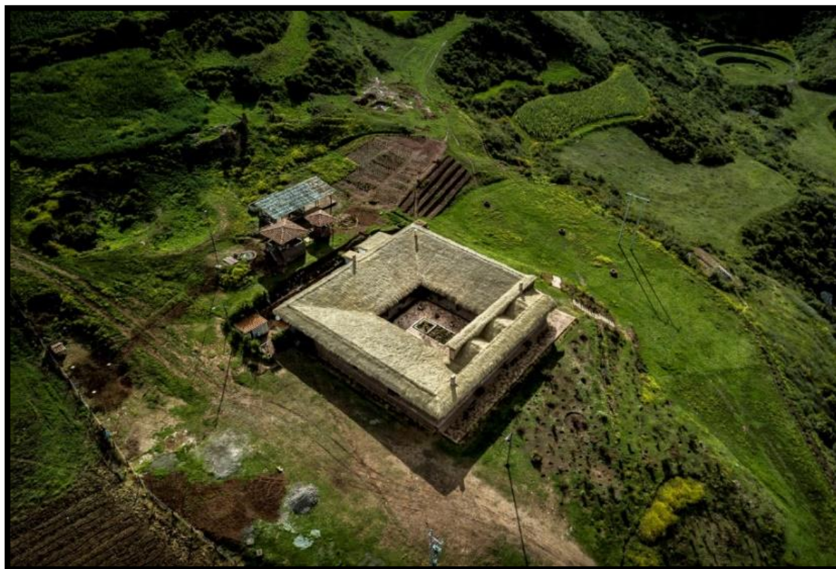
Figura 16: Vista de cima
