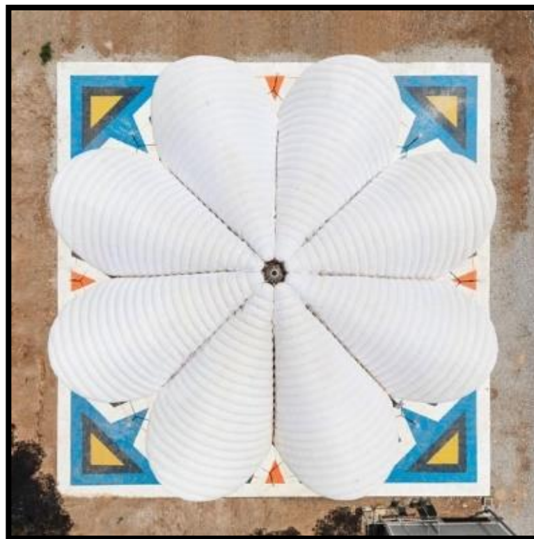
Figura 12: Vista de cima
