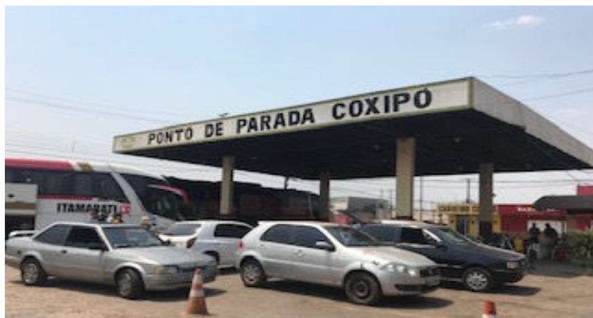
Figura 08: Ponto de Parada do Coxipó – Fachada e estacionamento
