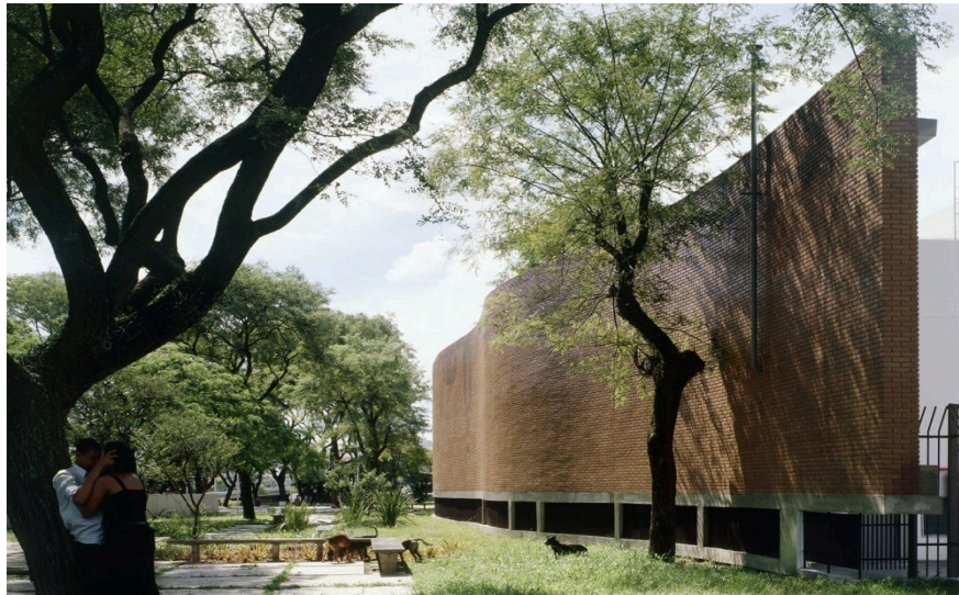
Figura 26: Fachada lateral – Detalhe das ondas
