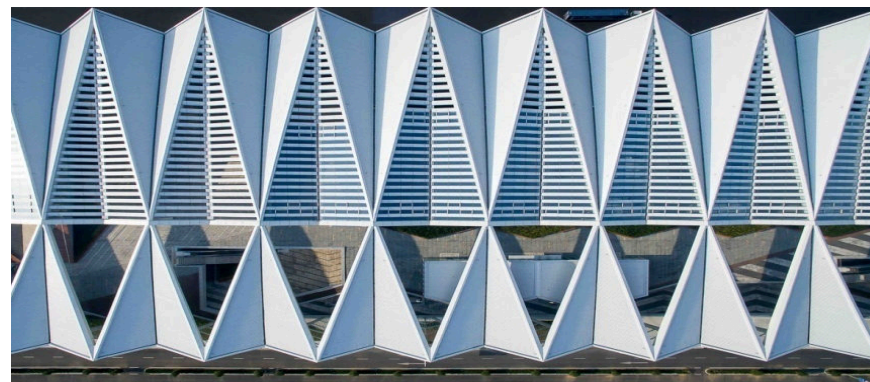
Figura 37: Detalhes do telhado
