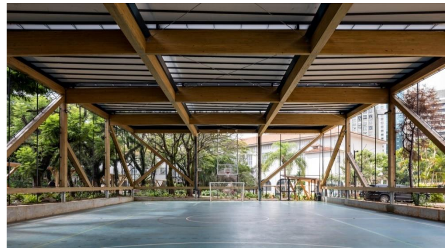
Figura 16: Estrutura da quadra.
