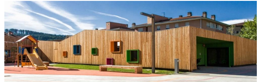
Figura 06: Fachada da edificação
