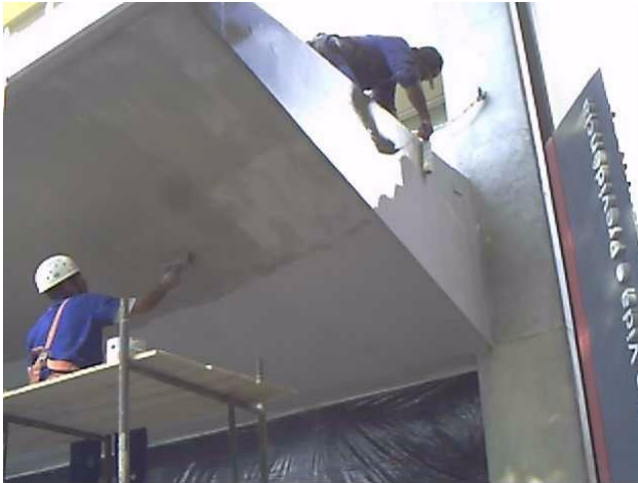
Figura 39 - Aplicação do concreto aparente.
