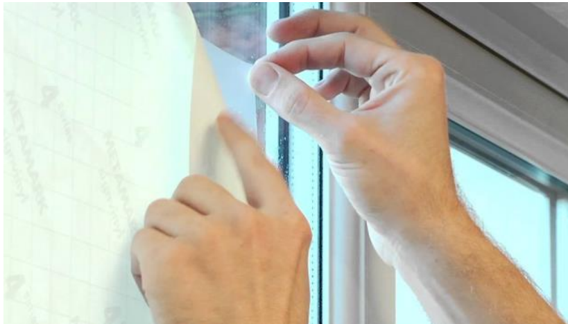
Figura 37- Aplicação da película de vidro.
