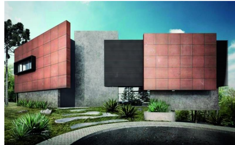
Figura 40 - Fachada em concreto aparente.
