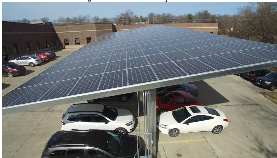
Figura 78: Cobertura com placa solar
