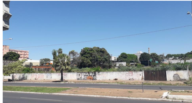
Figura 45: Fachada do terreno voltada para a Av. Ten. Cor. Duarte.
