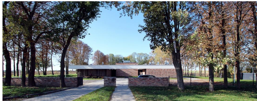
Imagem 28: Fachada Abrigo de Jankowice
