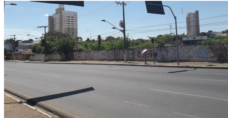
Figura 47: Fachada do terreno voltada para a Av. XV de Novembro.
