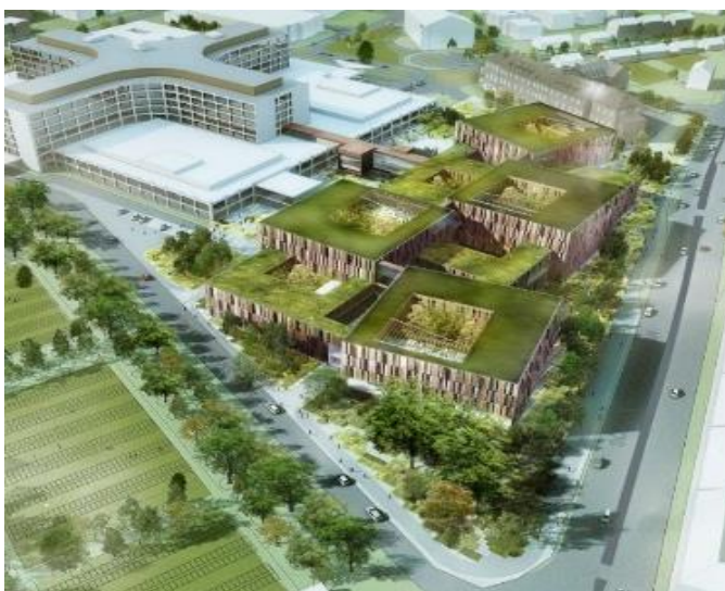
Figura 23 – Terraço jardim da edificação
