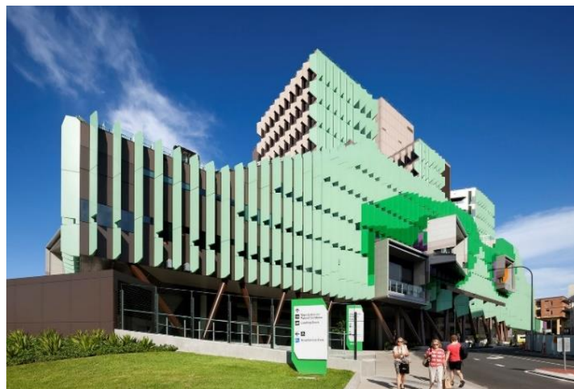
Figura 22 – Fachada Hospital Infantil Lady Cilento
