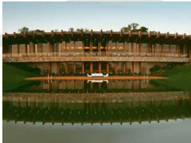
Figura 10: Fachada Hotel Fasano
