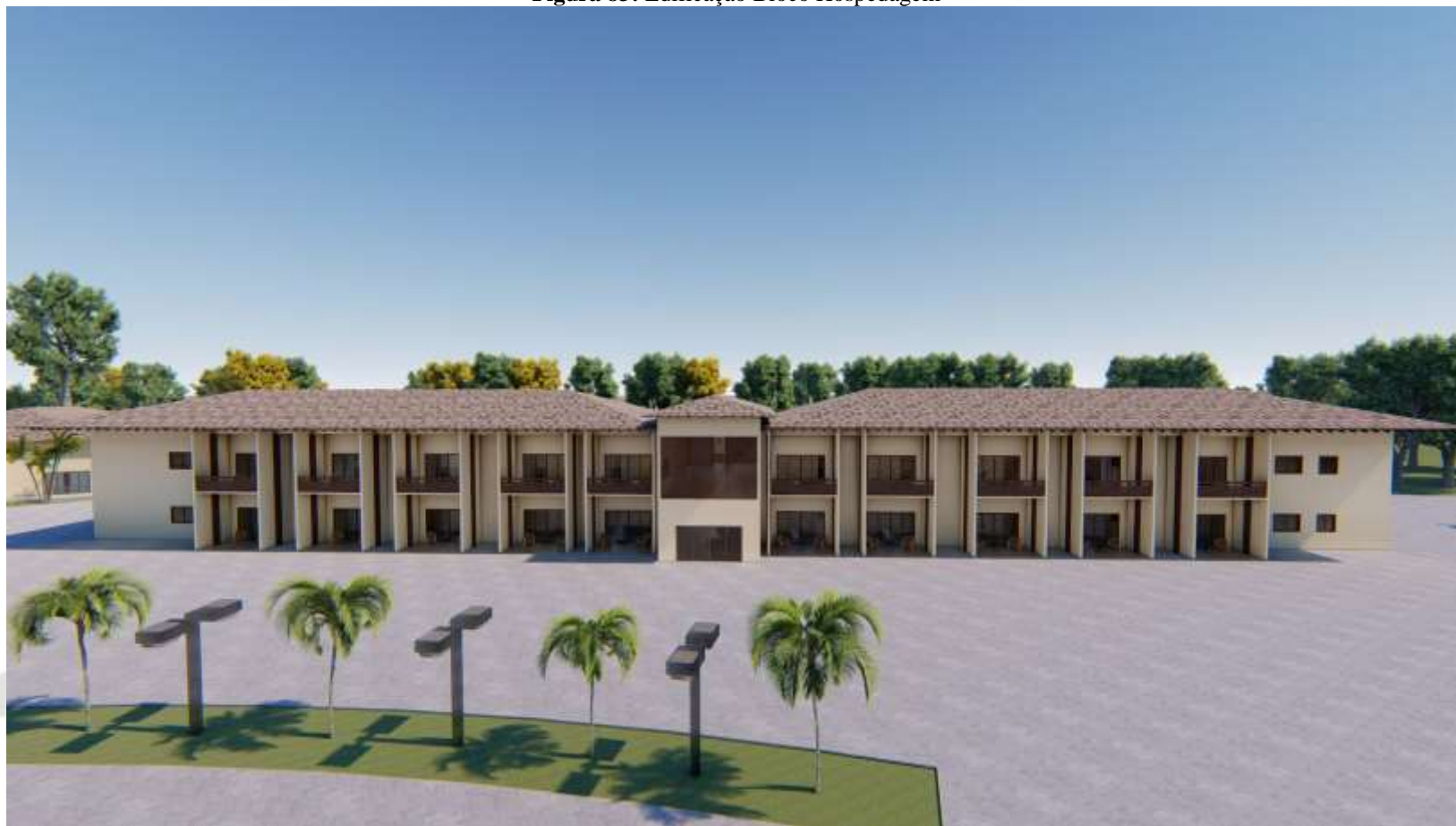
Figura 83: Edificação Bloco Hospedagem
