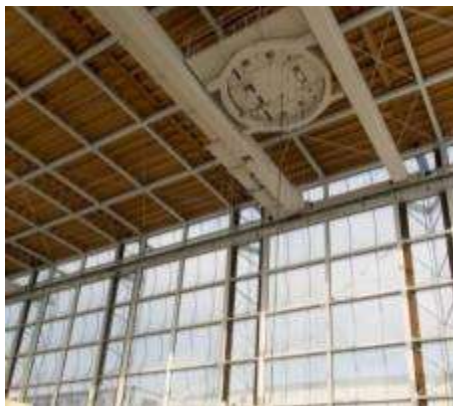
Figura 03: Revestimento do salão em madeira e vidro, o qual permite a entrada de iluminação natural.
