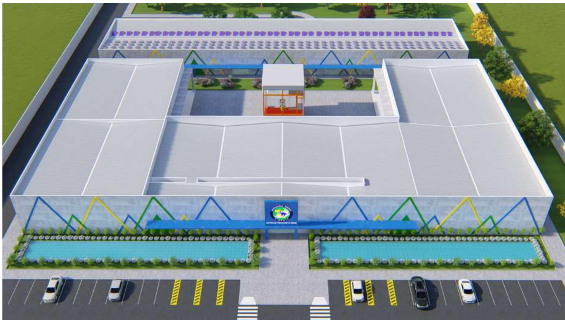
Figura 44: Vista aérea da implantação.
