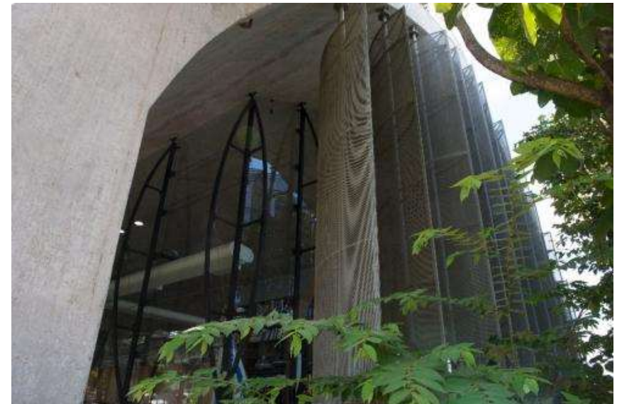
FIGURA 74: BRISES DA FACHADA FRONTAL.
