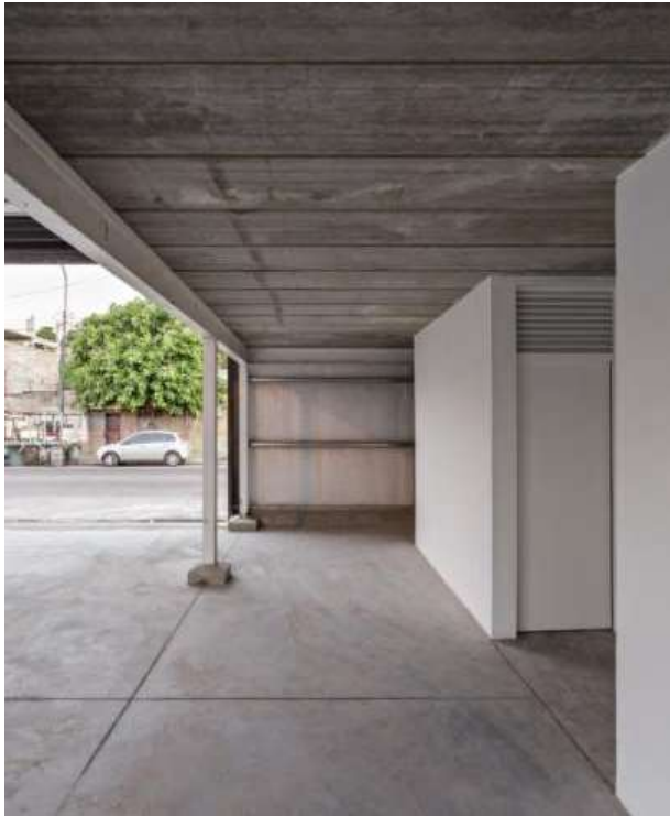
FIGURA 23: FACHADA EM ALVENARIA.
