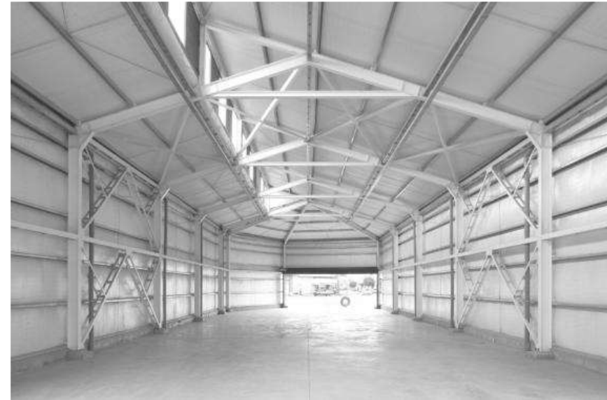
FIGURA 22: INTERIOR DO GALPÃO CASERO.
