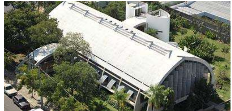
FIGURA 72: COBERTURA DO EDIFÍCIO.
