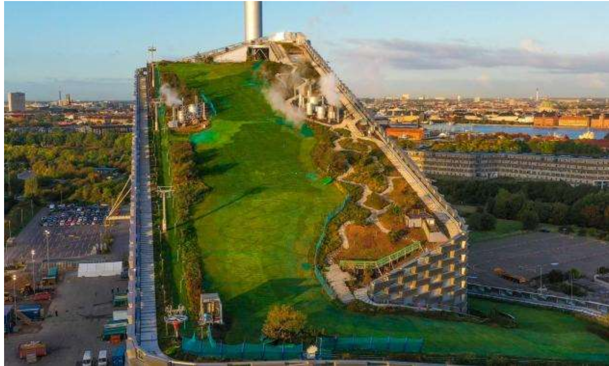
FIGURA 36: TERRAÇO DO EDIFÍCIO.
