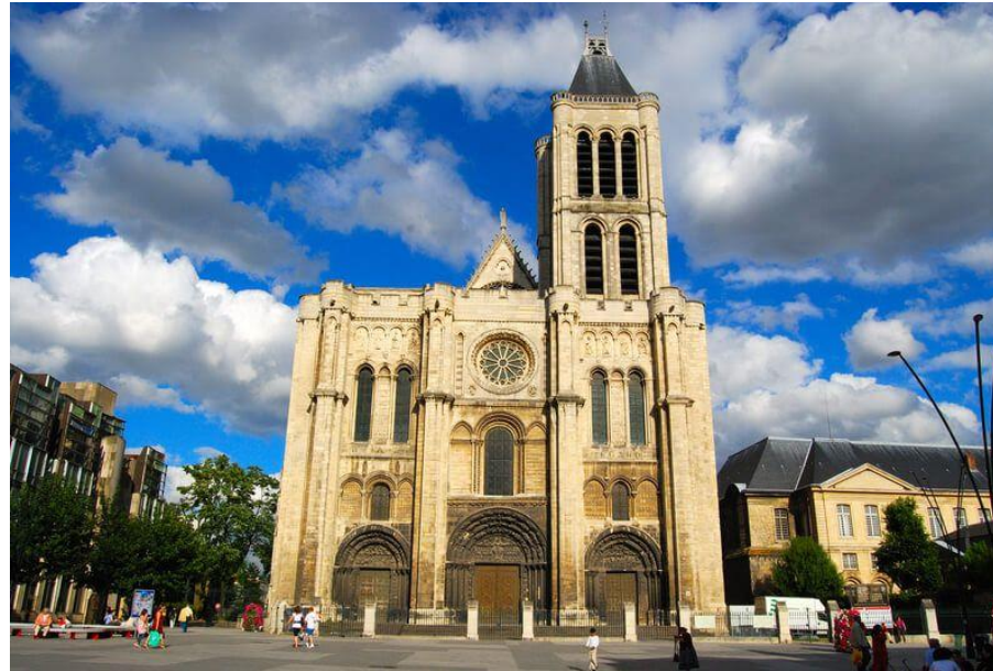
Figura 20 - Fachada da Catedral de Saint Denis
