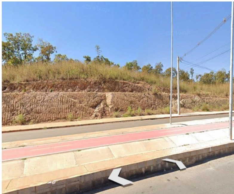
Figura 57 - Terreno Av. Rodovia Helder Candia
