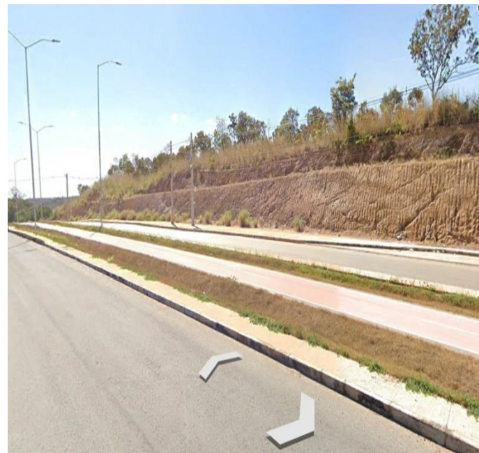
Figura 58 - Terreno Av. Rodovia Helder Candia
