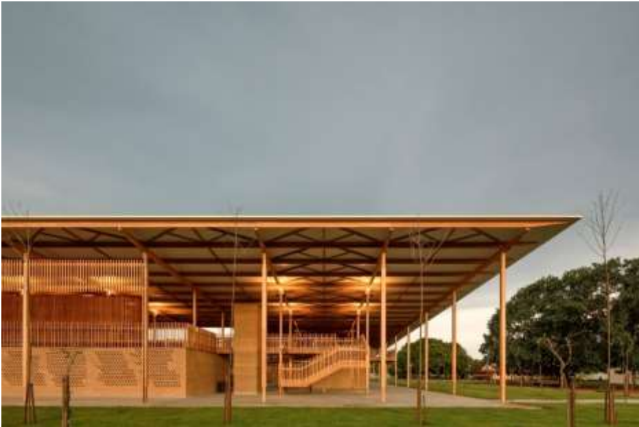
Figura 16: Fachada Moradias infantis
