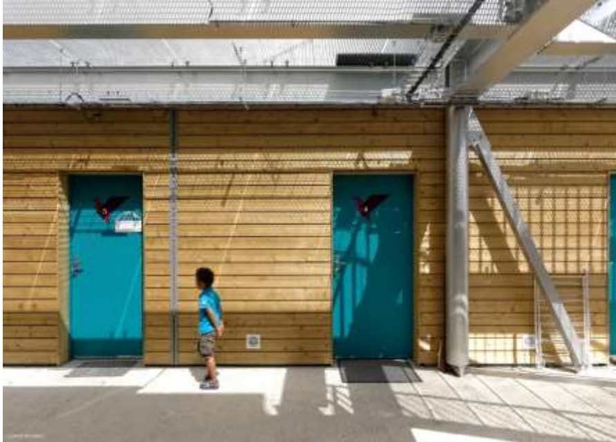
Figura 38: Dormitórios do Alojamento
