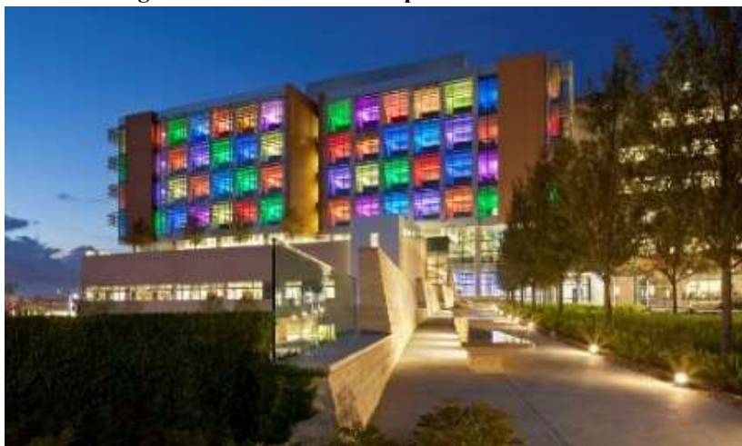
Figura 13 - Fachada do Hospital Infantil Nemours
