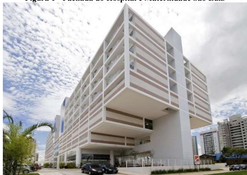
Figura 1 - Fachada do Hospital e Maternidade São Luiz
