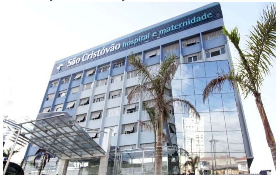
Figura 7 - Fachada Hospital e Maternidade São Cristóvão
