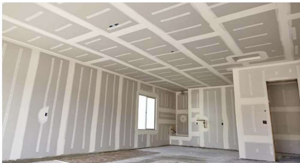
Figura 35: Sistema de vedação drywall.
