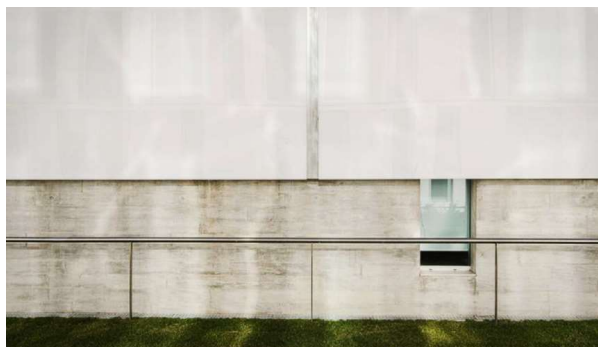
Figura 17: Concreto armado e cobertura em acrílico.
