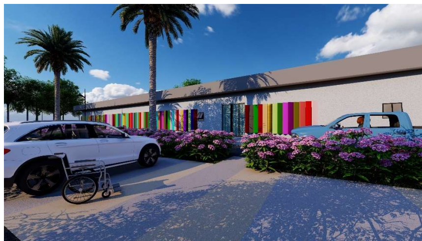
Figura 103: Imagem da fachada com brises verticais e painéis em aço cortén.
