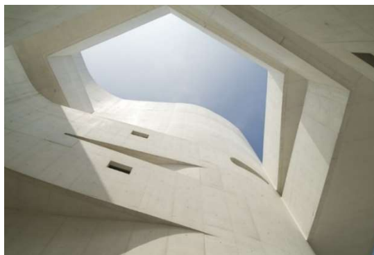
Figura 69: Detalhe das rampas para circulação vertical.
