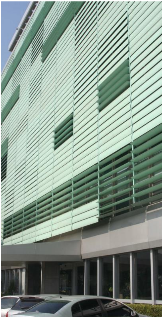
Figura 27 - Termobrise, utilizado na posição horizontal em fachadas.
