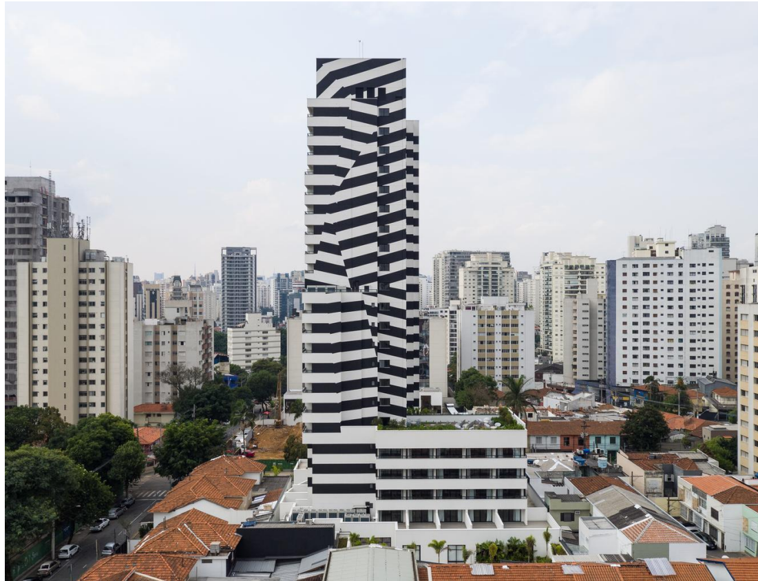
Figura 10 - Fachada posterior, Kasa.
