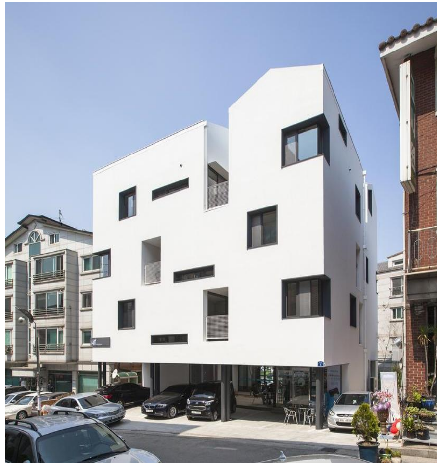
Figura 7 - Fachada frontal, Capa Gap.
