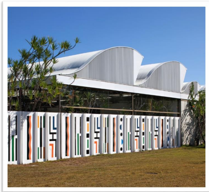
Figura 33: Cobertura em Shed
