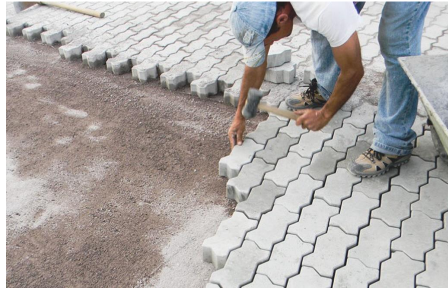
Figura 39 – Piso intertravados aplicação;
