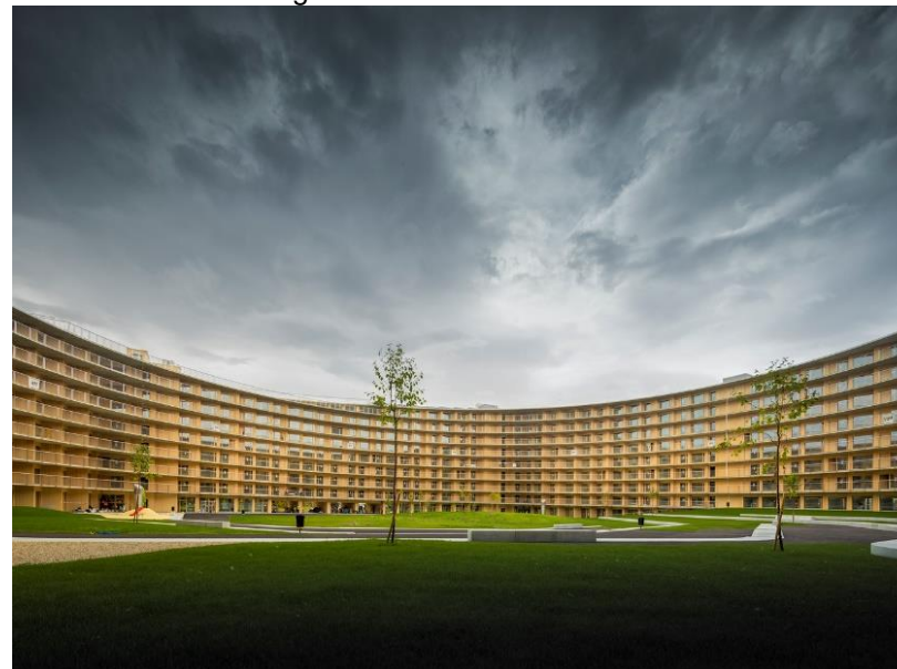
Figura 3 – Fachada do Vórtex
