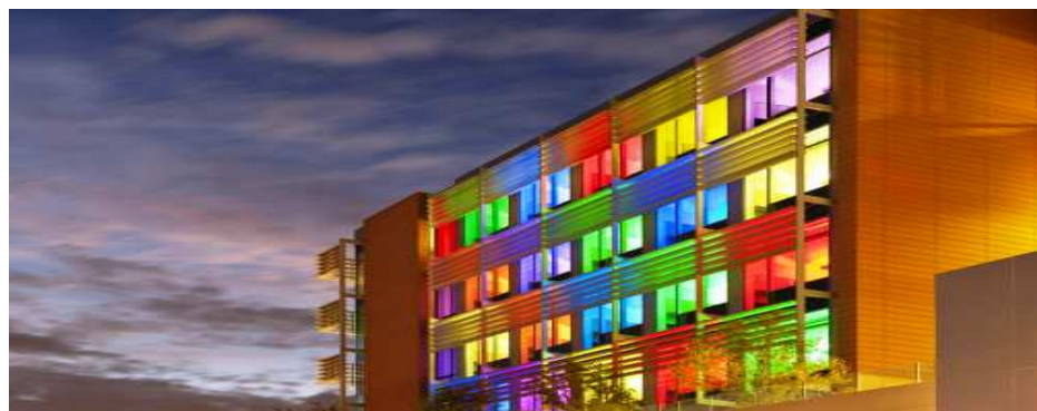
Figura 14- Fachada em período noturno Fonte: Archdaily, 2019.
