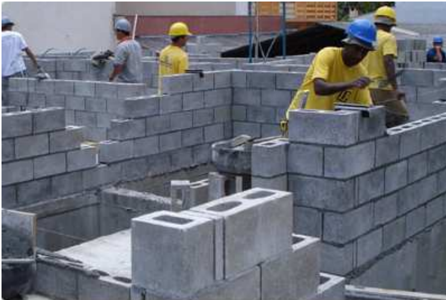
Figura 38 – Paredes com bloco de concreto Fonte: Wetterlt, 2021.
