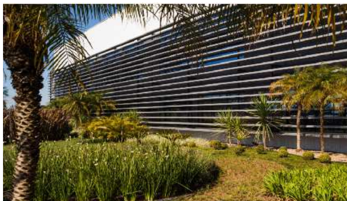
Figura 30 - Sistema de Brises Fonte: ArchDaily, 2017.
