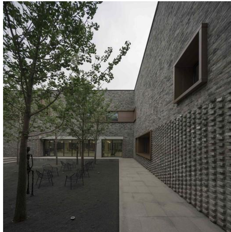
Figura 9: Aberturas de janelas em jardim interno da edificação
