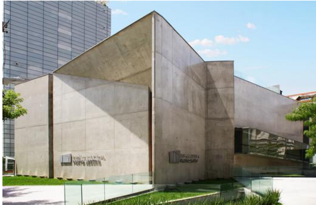
Figura 16: Fachada secundara da edificação
