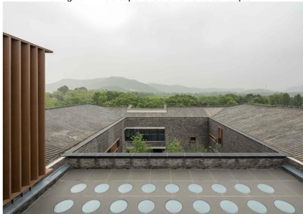
Figura 7: Vista superior do entorno da edificação
