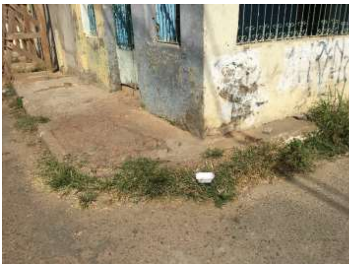
Figura 43: Foto da via calçamento esquina com Trav. Padre Masseratti. Fonte: Próprio Autor. (2021)
