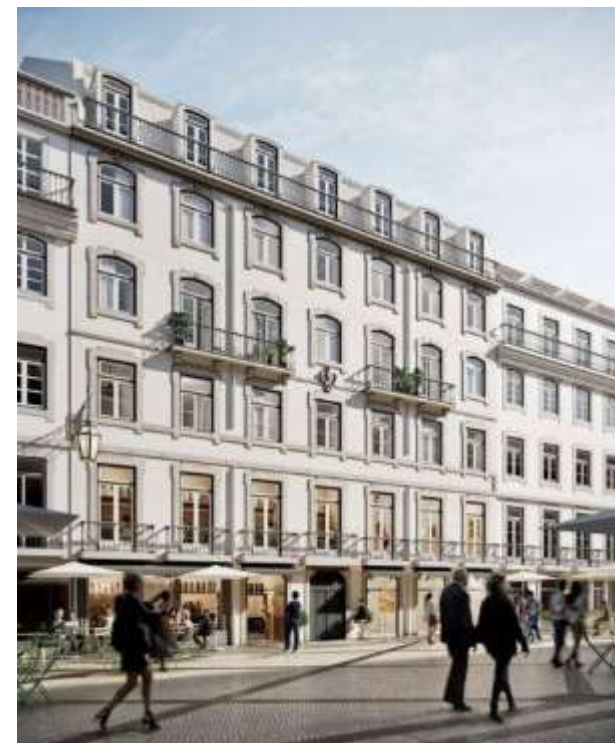
Figura 21: Fachada do edifício residencial após reabilitação. Fonte: https://vejasp.com (2021)
