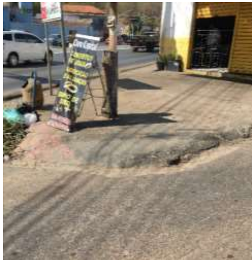
Figura 47: Foto do calçamento da via com esquina com Av. Tenente Coronel Duarte. Fonte: Próprio Autor. (2021)
