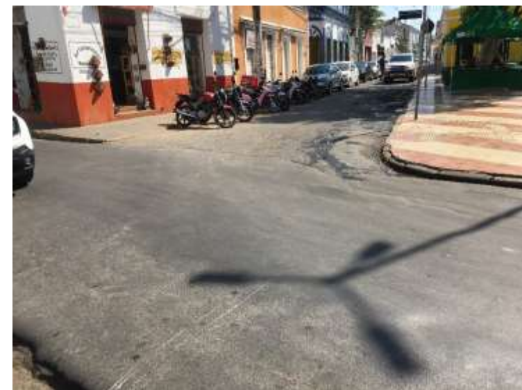
Figura 39: Foto da via esquina com R. Campo Grande. Fonte: Próprio Autor. (2021)
