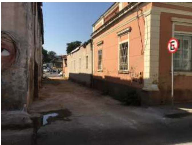
Figura 40: Foto da via beco ao lado do IPHAN. Fonte: Próprio Autor. (2021)
