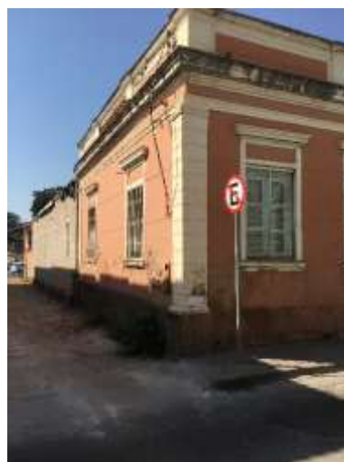
Figura 41: Foto da via beco ao lado do IPHAN. Fonte: Próprio Autor. (2021)
