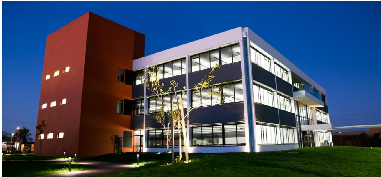
Figura 31 - Fachada – Sede Grupo DIMED.
