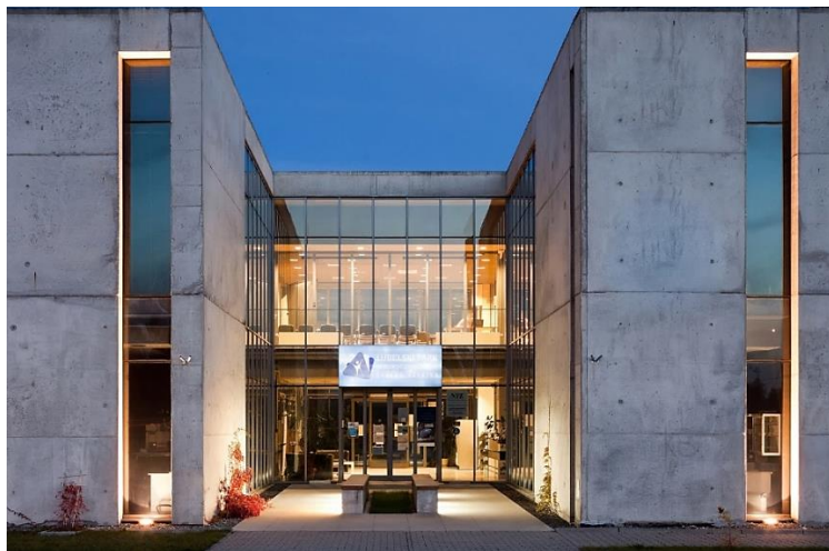
Figura 9 - Acesso principal - Parque Tecnológico e Científico Lublin.
