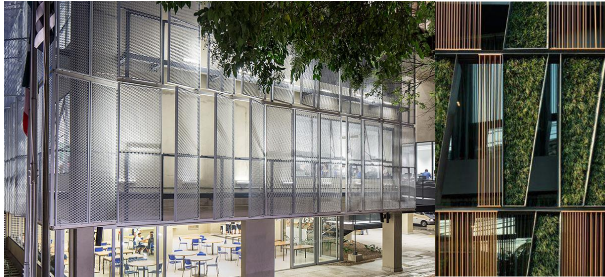
Figura 39 - Brise metálico perfurado e brise vegetal
