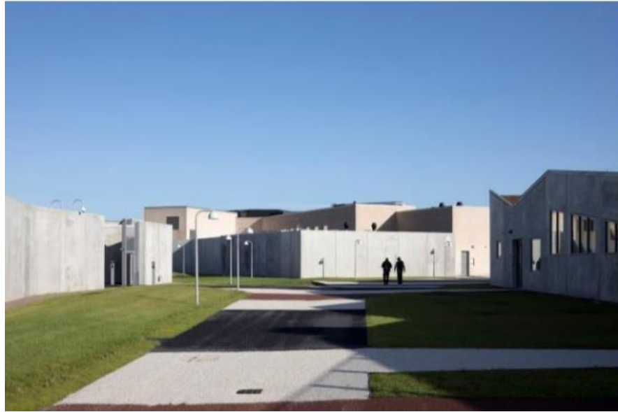
Figura 16 – Vista Externa 01 da Prisão Fonte: ArchDaily, 2017.
