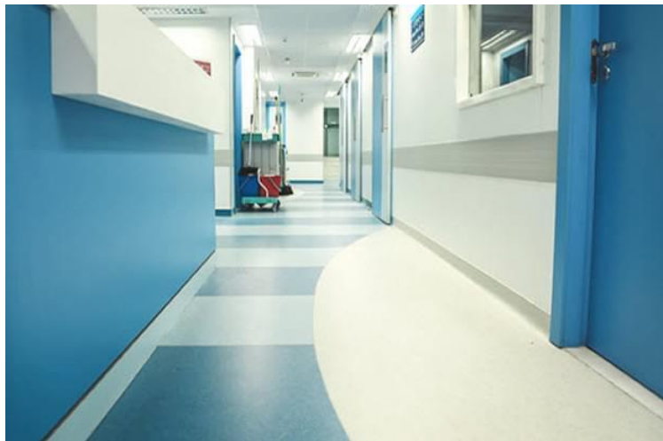
Figura 61 – Aplicação do Piso Vinílico Fonte: Google Imagens, 2021.
