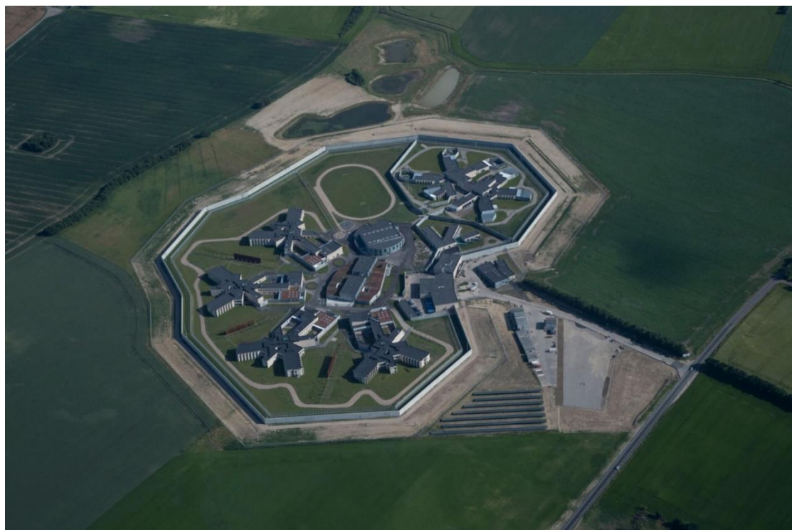
Figura 13 – Foto Panorâmica Prisão Storstrom Fonte: ArchDaily, 2017.
