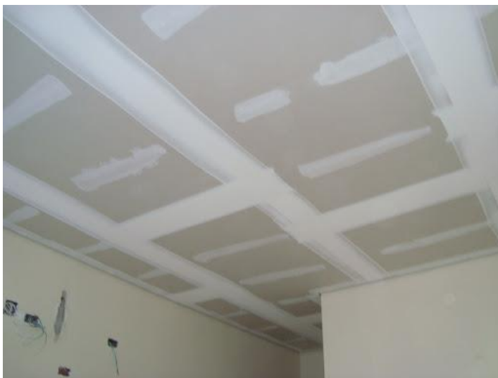
Figura 59 – Instalação de Gesso Acartonado Fonte: Google Imagens, 2021.
