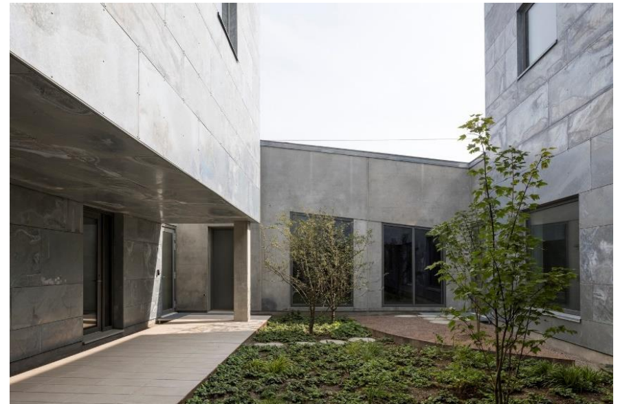
Figura 17 – Vista Externa 02 da Prisão Fonte: ArchDaily, 2017.
