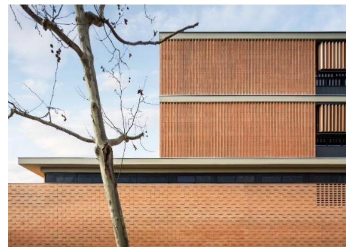
Figura 24 – Lâminas de cerâmica ajustáveis na fachada Fonte: ArchDaily, 2017.
