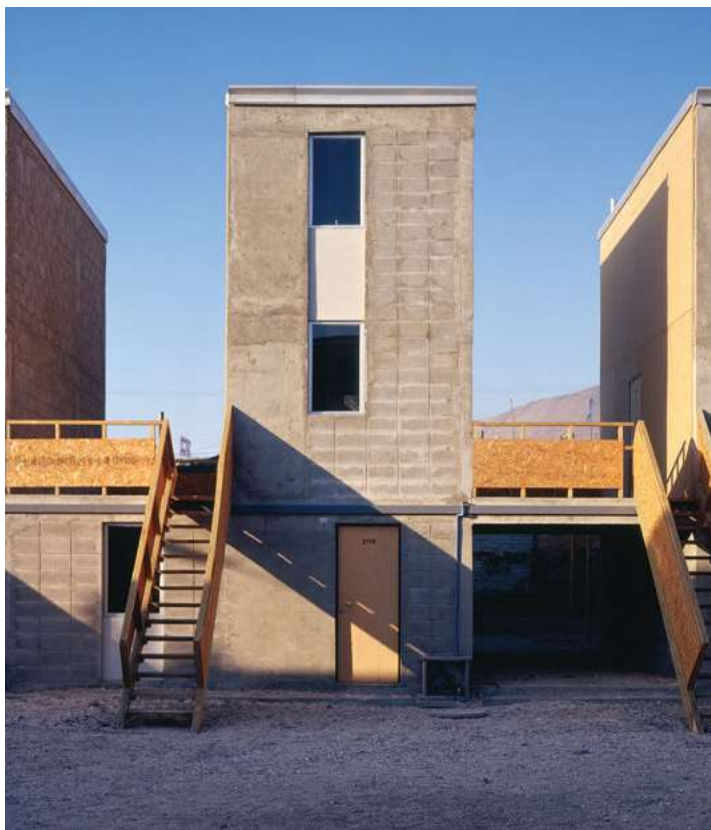
Figura 31 - Conjunto Habitacional Quinta Monroy - Projetada
