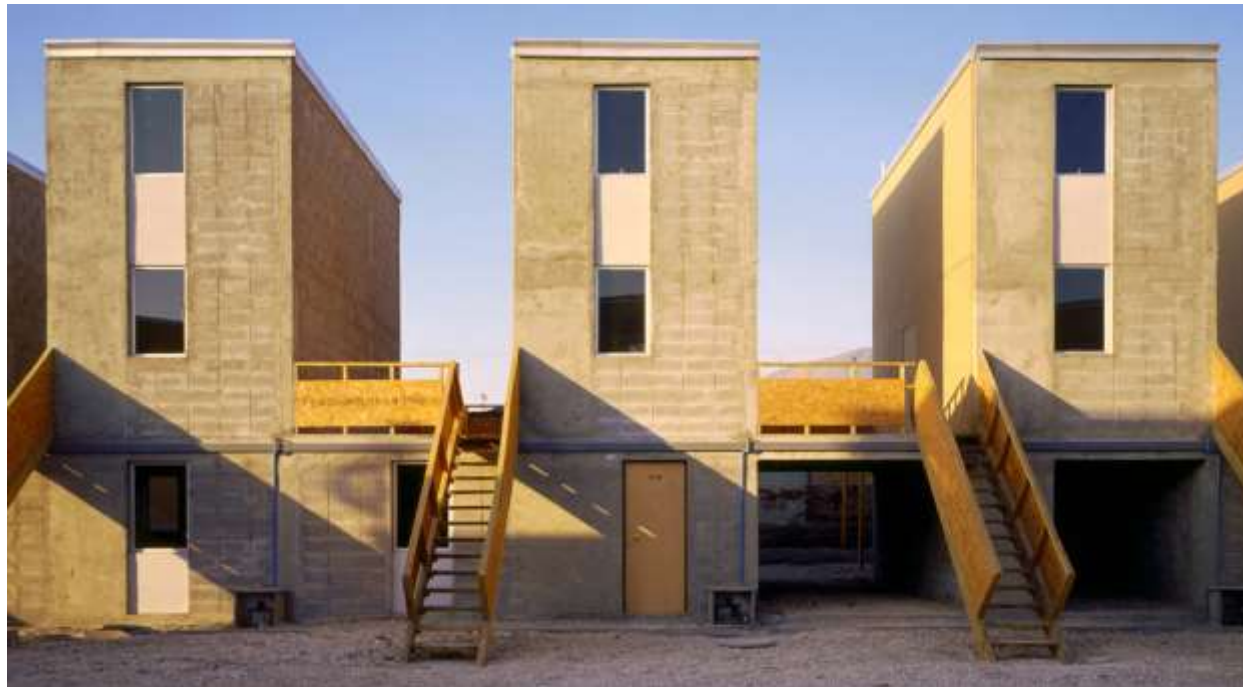
Figura 30 - Conjunto Habitacional Quinta Monroy – Habitações verticalizadas
