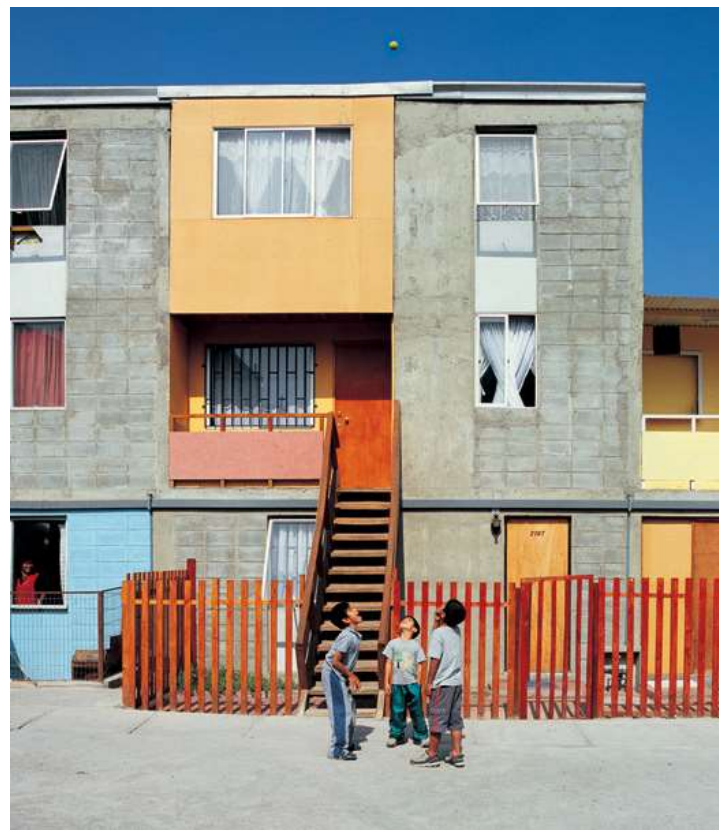
Figura 32 - Conjunto Habitacional Quinta Monroy - Ampliada
