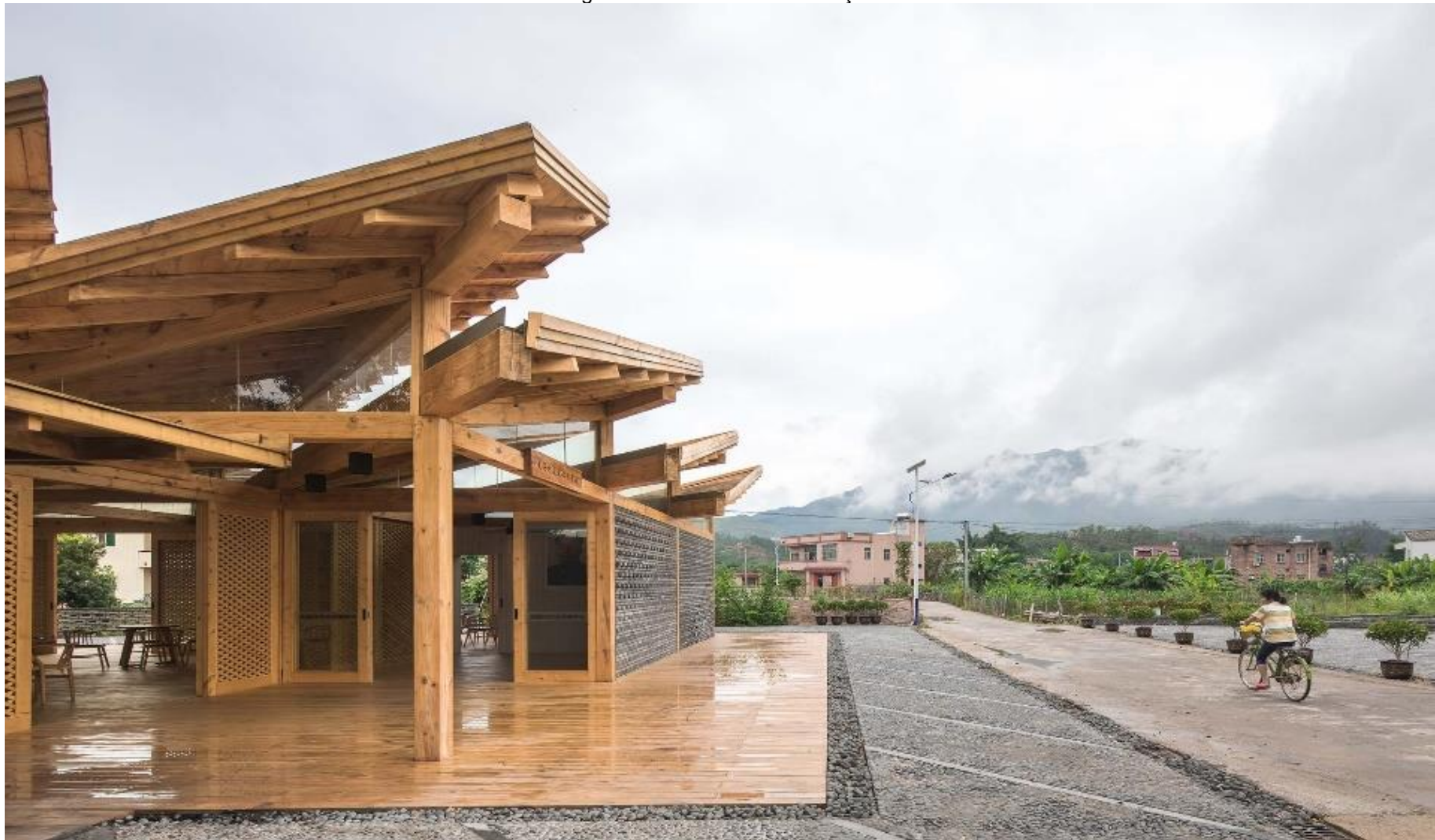
Figura 18: Fachada da Edificação
