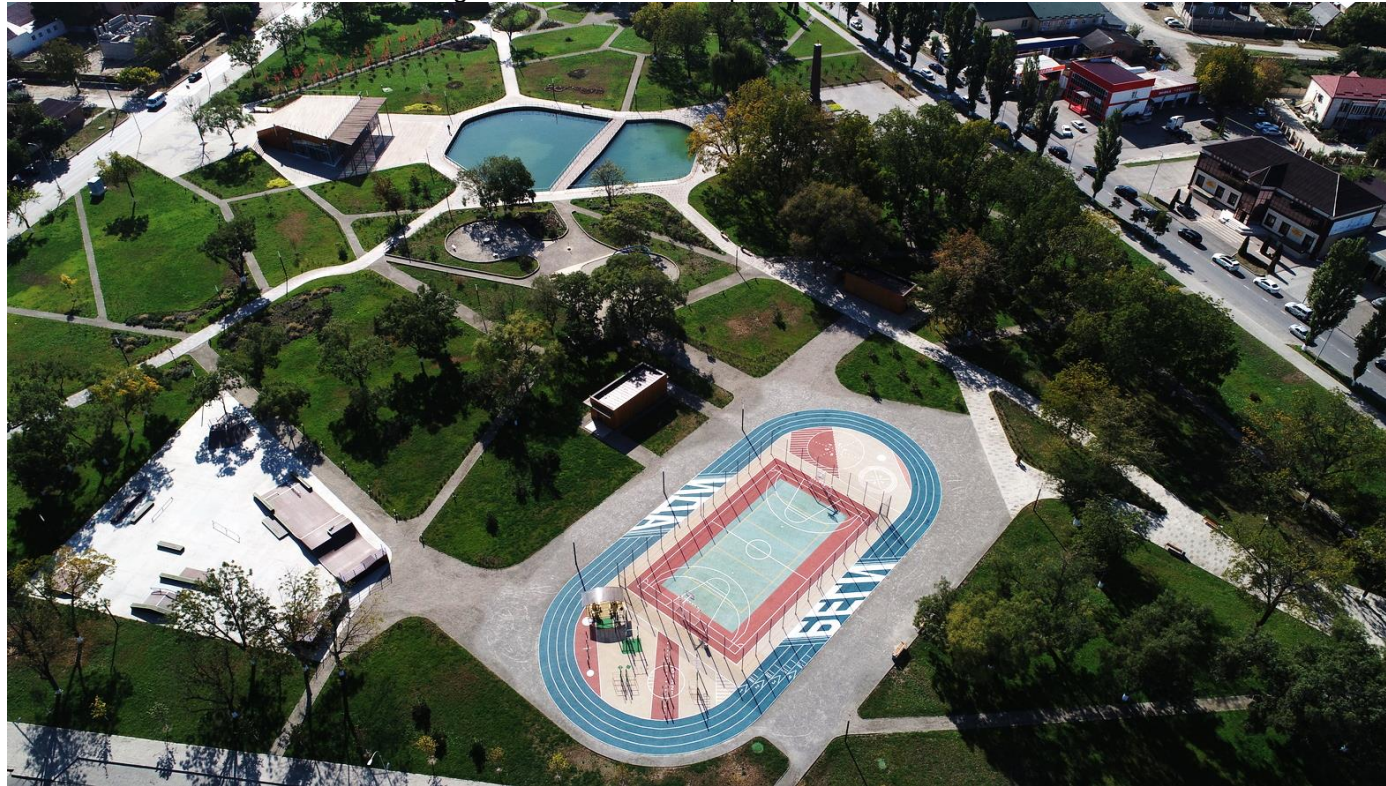
Figura 4: Visão área Parque Hessein Bin Talal
