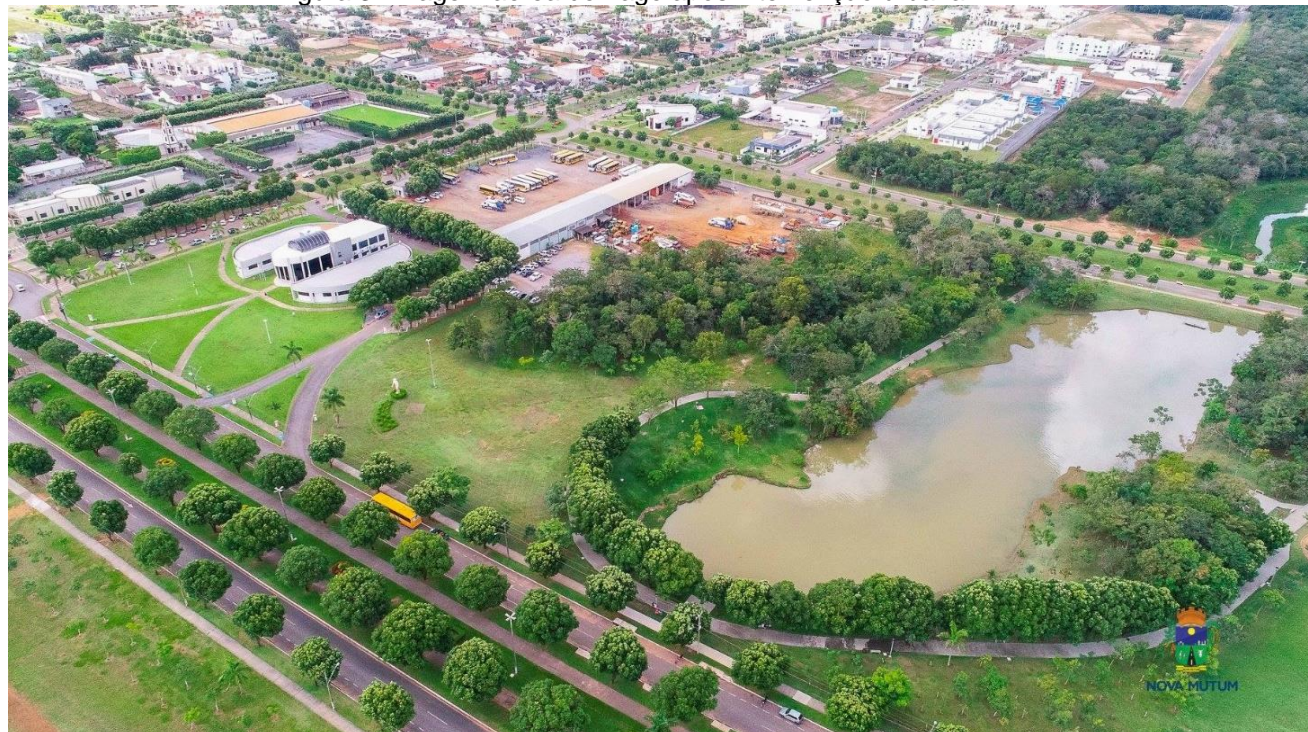
Figura 3: Imagem aérea do Lago após intervenção urbana
