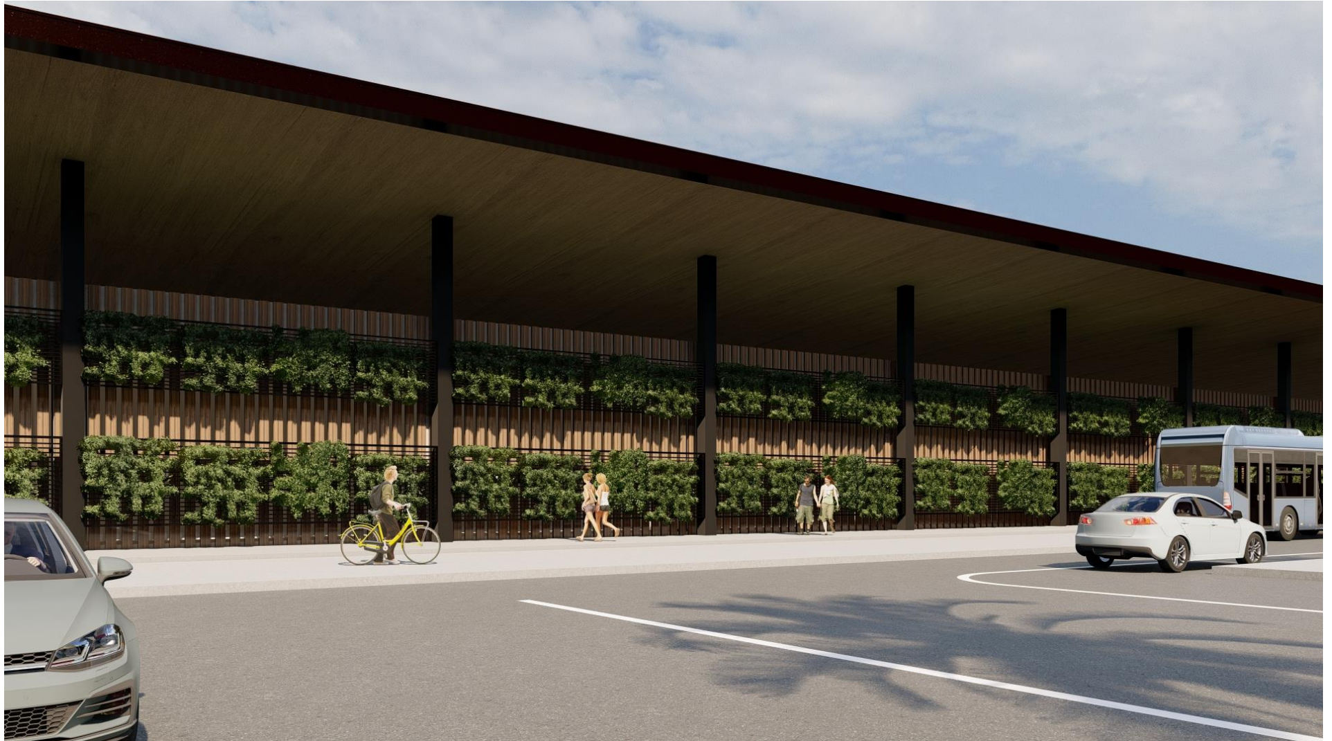
Figura 89: Fachada Bloco Pedagógico
