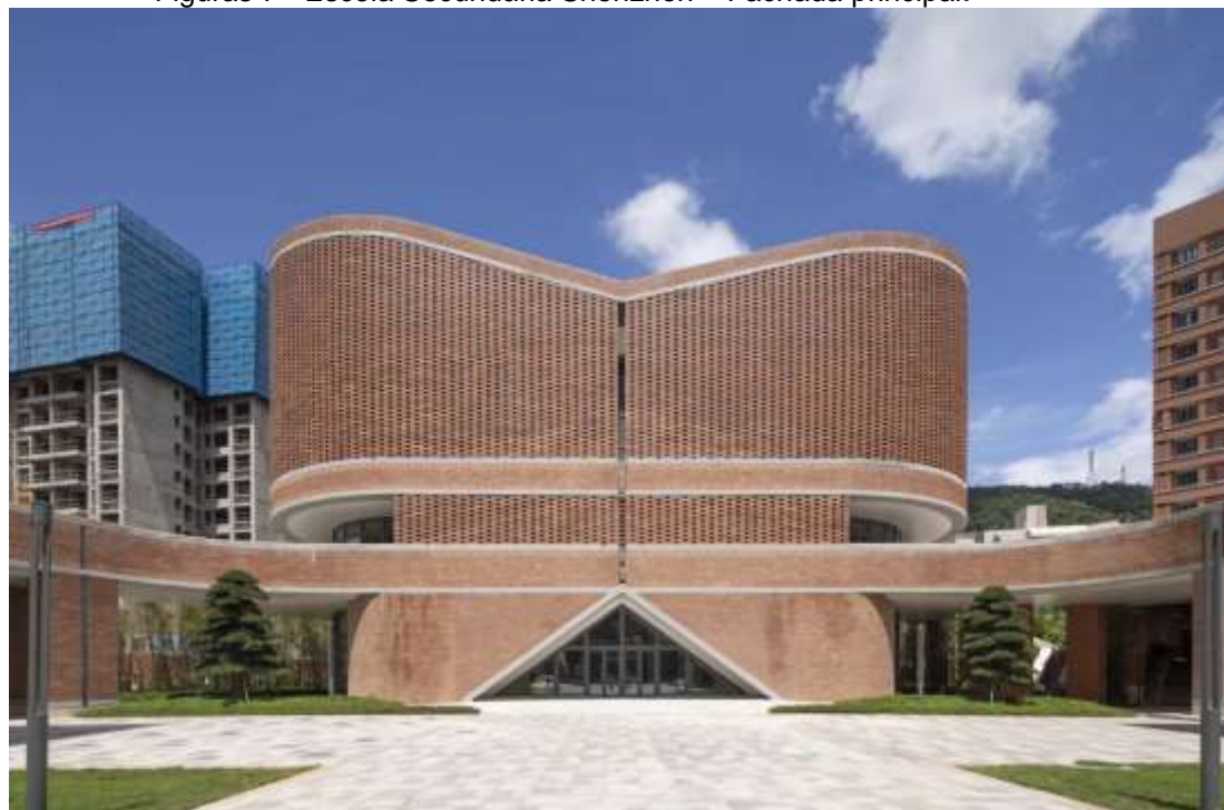
Figuras 7 - Escola Secundária Shenzhen – Fachada principal.
