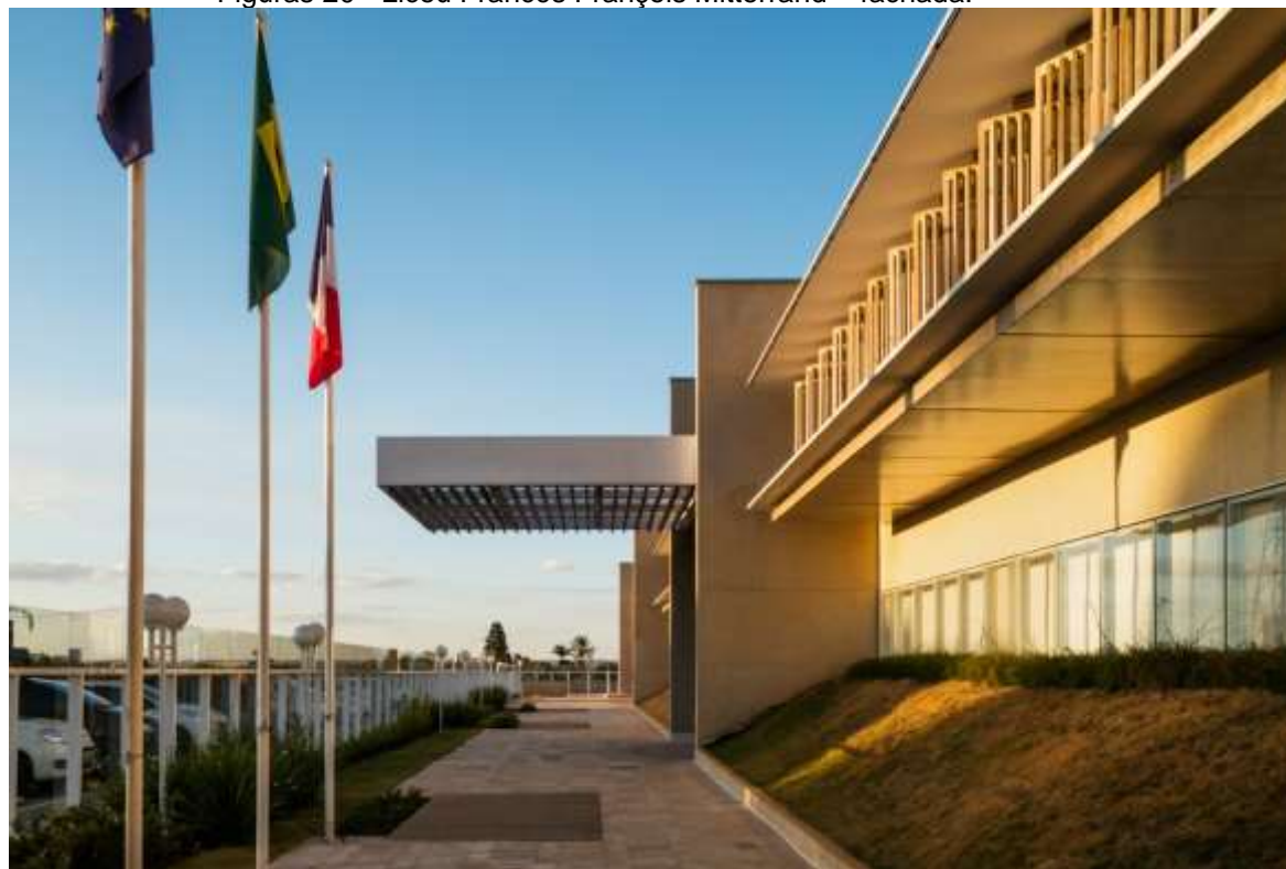
Figuras 20 - Liceu Francês François Mitterrand – fachada.
