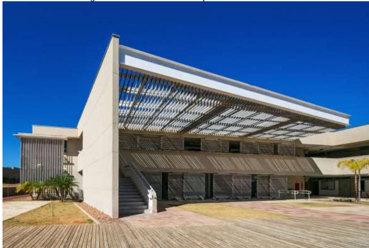
Figuras 19 - Liceu Francês François Mitterrand - fachada
