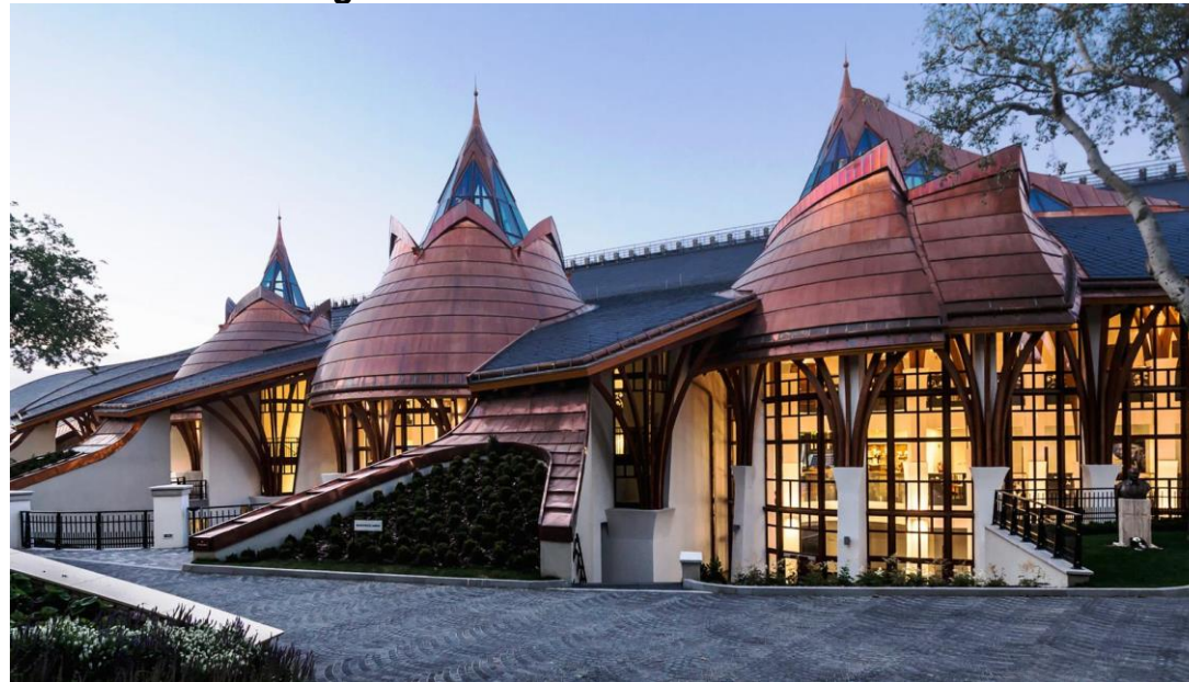
Figura 25– Dormitório Arena Pancho
