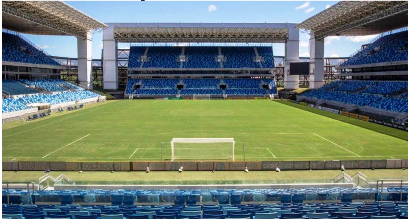
Figura 17: Arena Pantanal Interna
