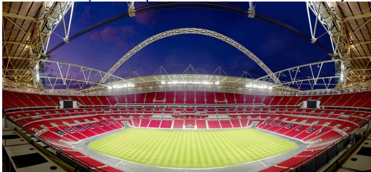
Figura 21 – Vista Interna e Posições das Arquibancadas do Estádio Nacional Wembley / Foster + Partners
