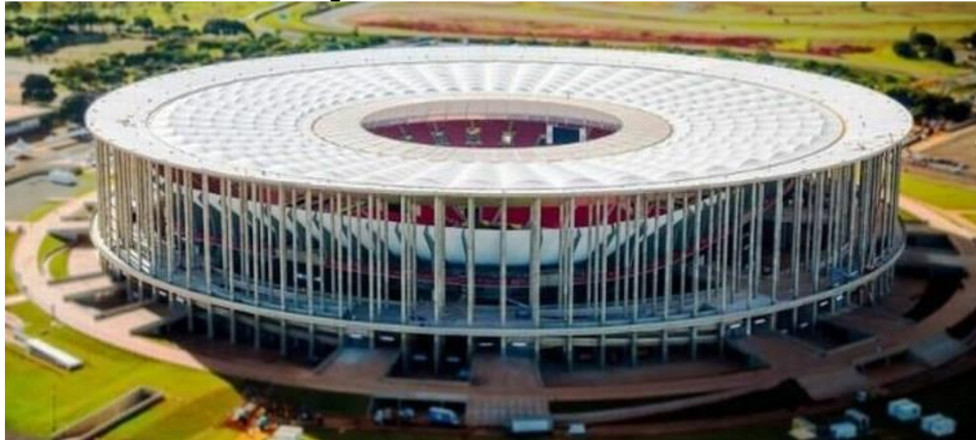
Figura 02: Estádio Mané Garrincha
