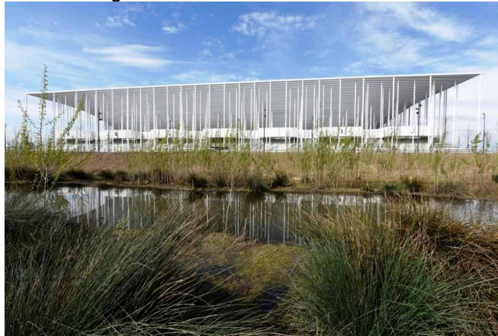
Figura 23 – Estádio de Bordeaux Externa
