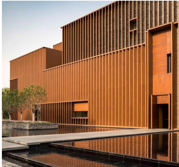
Figura 19 - Fachada Fonte: Neri And hu (2020)
