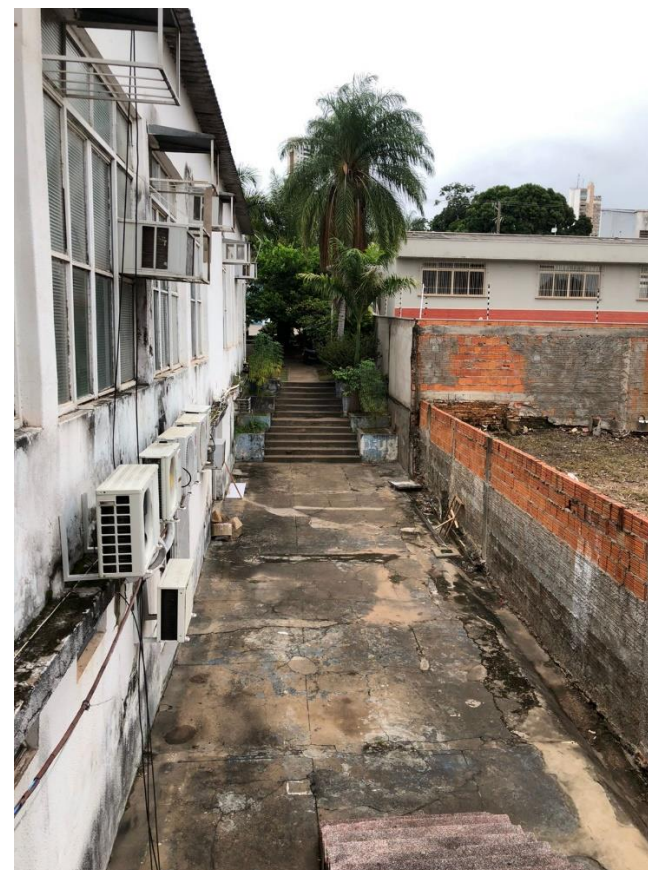
Figura 48: Vista janela biblioteca Fonte: próprio autor. (2022)
