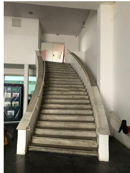
Figura 44: Escada principal Fonte: próprio autor. (2022)
