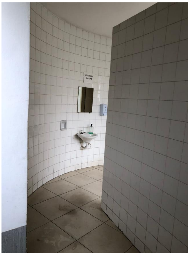
Figura 49: Banheiro Fonte: próprio autor. (2022)
