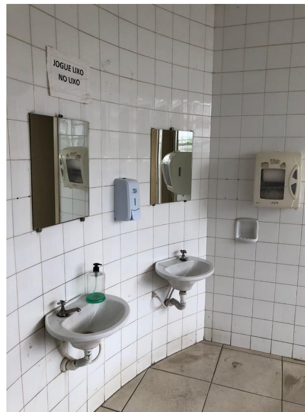
Figura 50: Banheiro Fonte: próprio autor. (2022)
