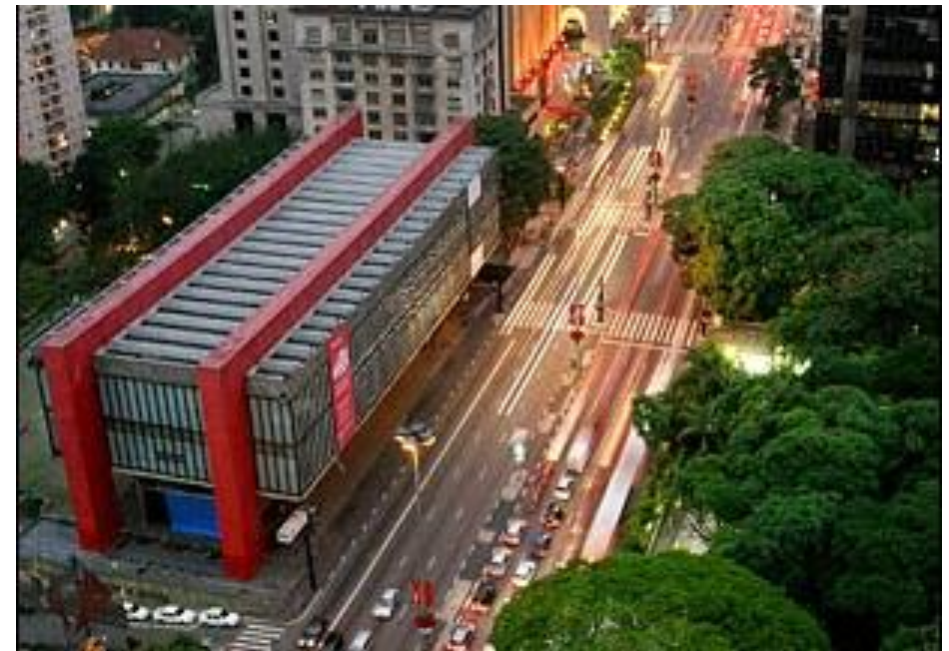
Figura 23 - Vista Aérea MASP Fonte: Archdaily (2012)
