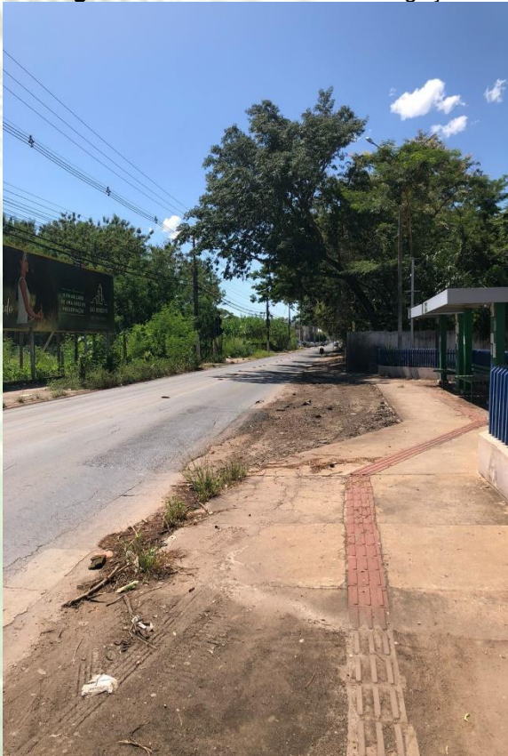
Figura 44: Avenida Barão de Melgaço.
