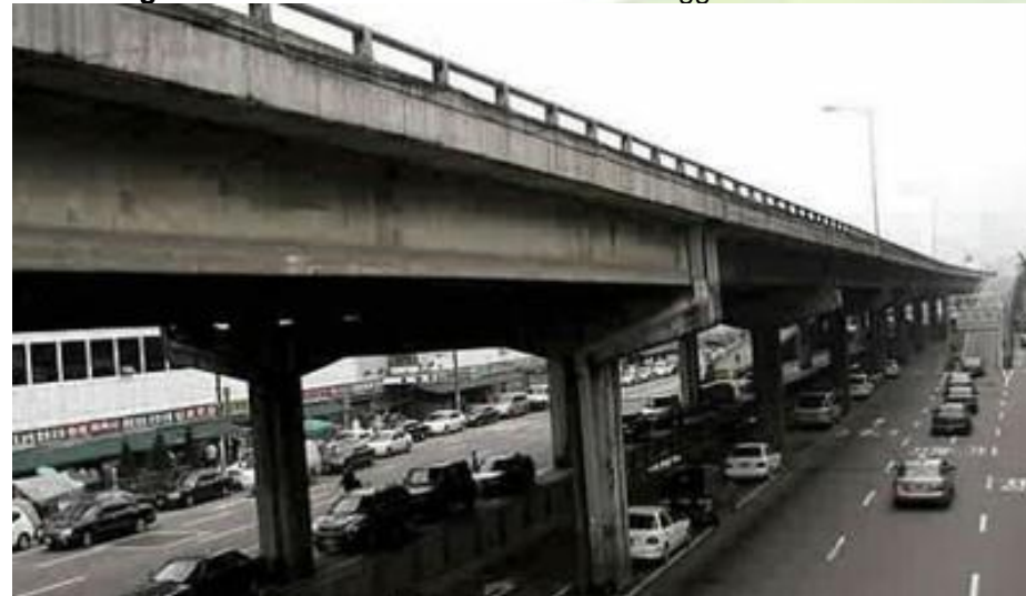
Figura 10: Primeiro viaduto sobre o rio Qinguichuan em Seúl.
