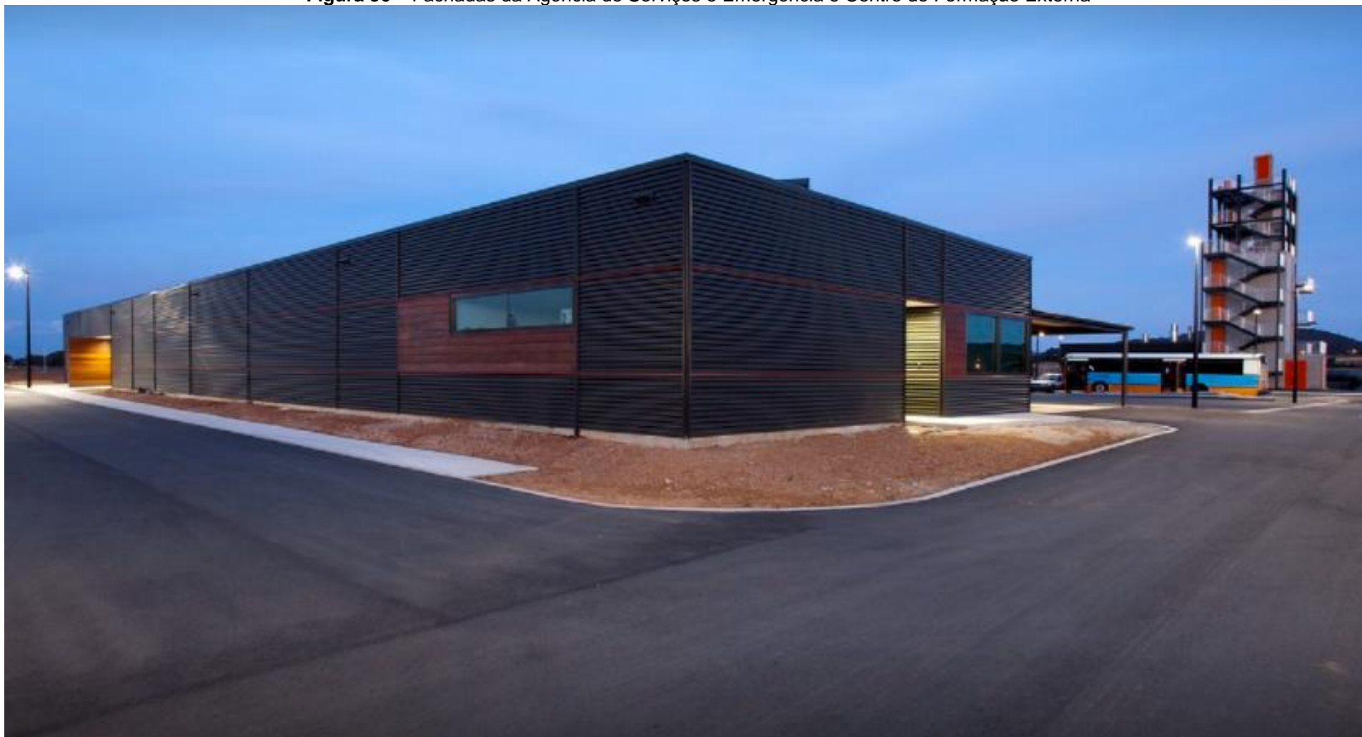
Figura 36 – Fachadas da Agência de Serviços e Emergência e Centro de Formação Externa
