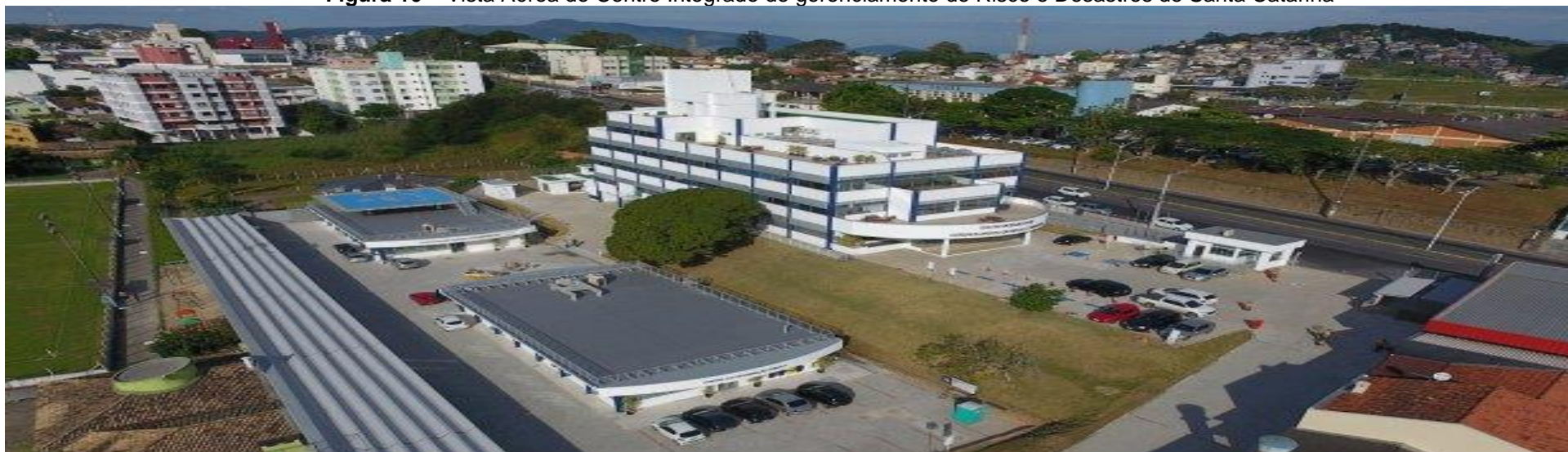
Figura 10 – Vista Aérea do Centro Integrado de gerenciamento de Risco e Desastres de Santa Catarina
