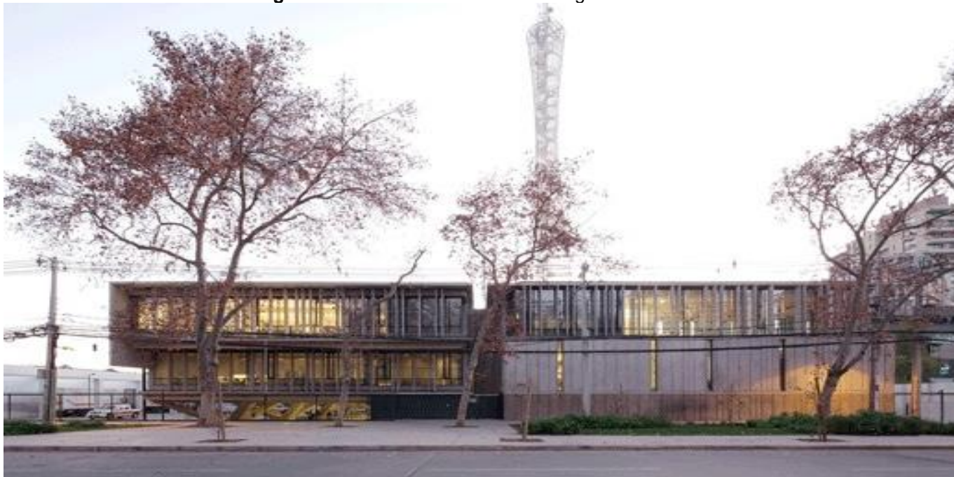
Figura 21 – Edifício Nacional de Emergências do Chile
