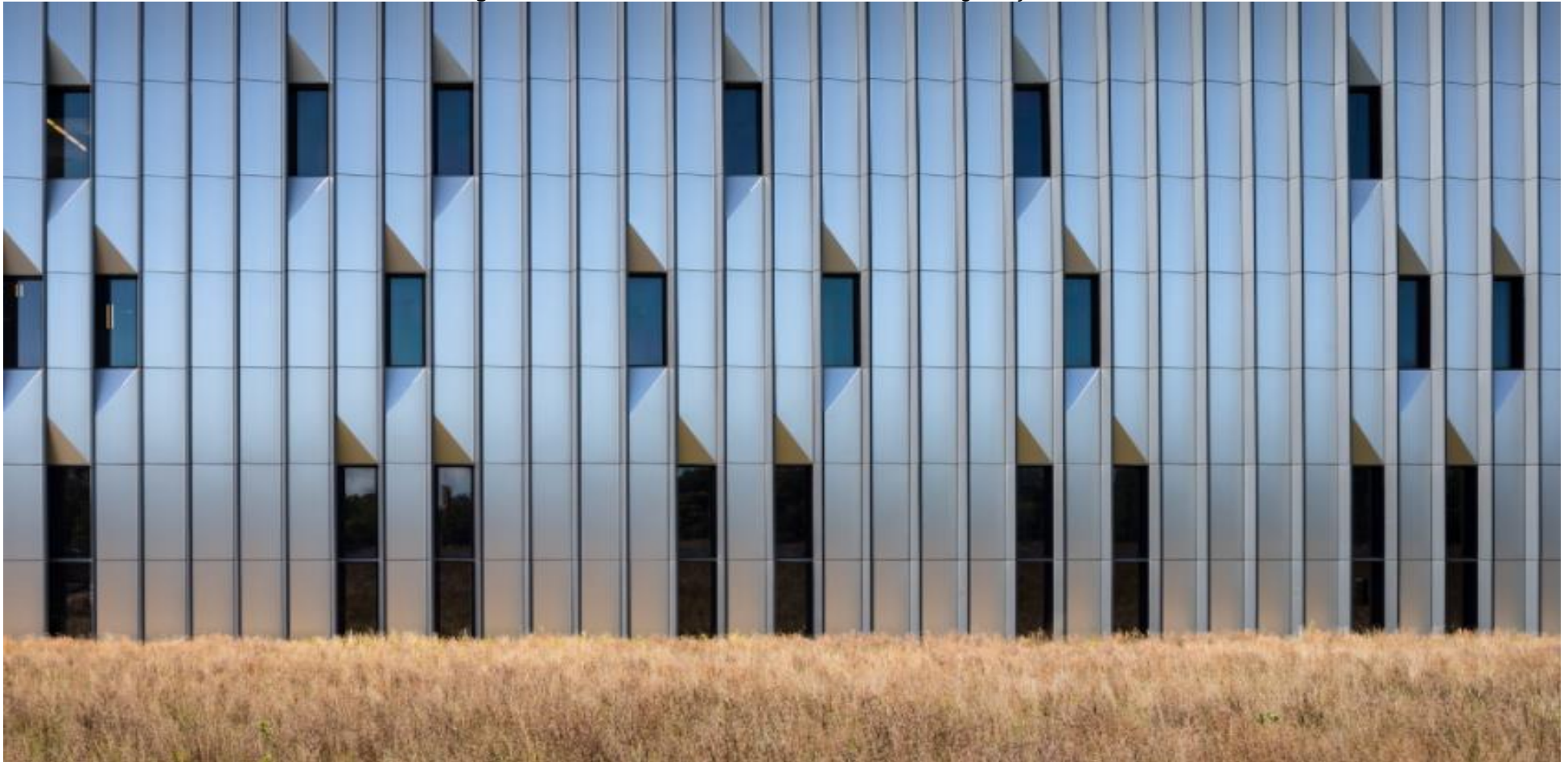
Figura 30 - Fachada do Centro de Atendimento e Segurança Pública
