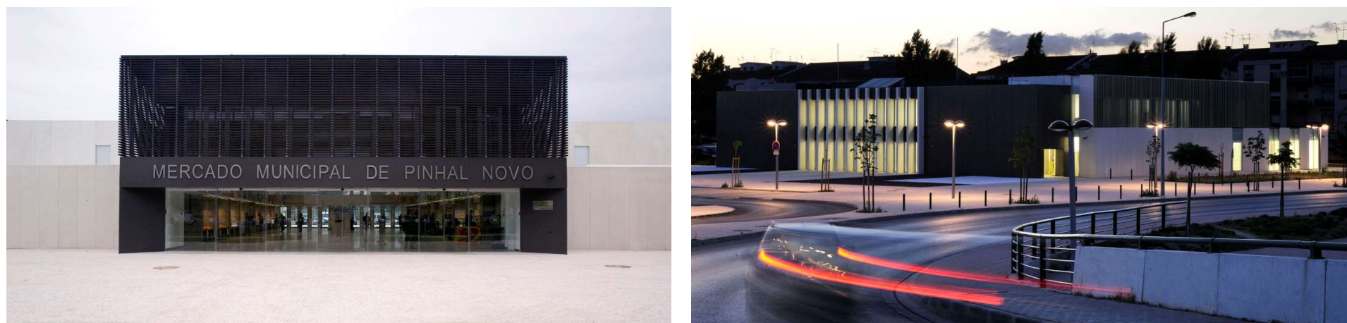
Figura 42: Fachada - Mercado Municipal de Pinhal novo
