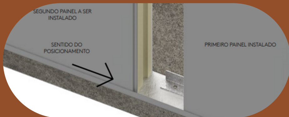
FIGURA 33: INSTALAÇÃO PAINEL SMARTWALL.
