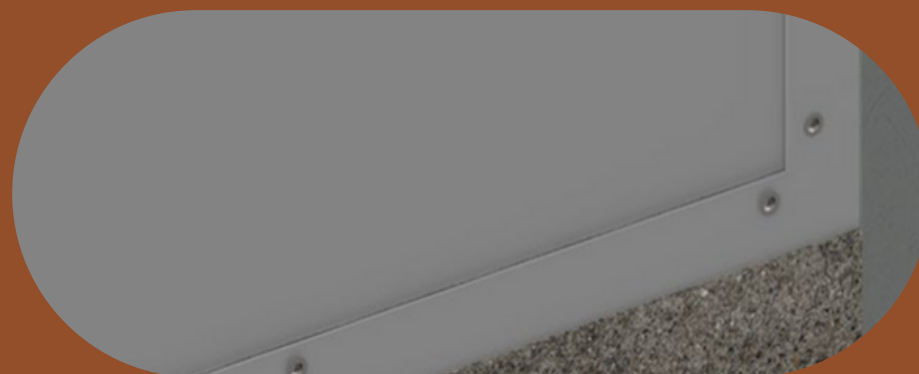
FIGURA 34: INSTALAÇÃO PAINEL SMARTWALL.
