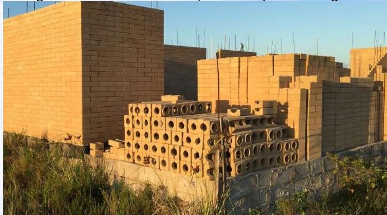
Figura 33 - Casa em execução com tijolos ecológicos.
