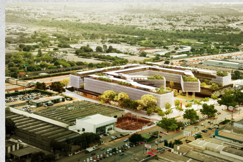
Figura 32 - Vista geral/ Complexo SIA
