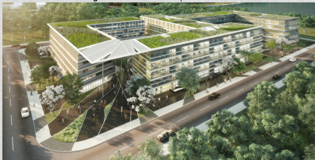
Figura 34 - Fachada/ Complexo Multiuso
