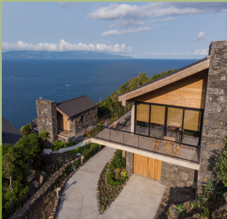
Figura 06: Fachada das instalações.
