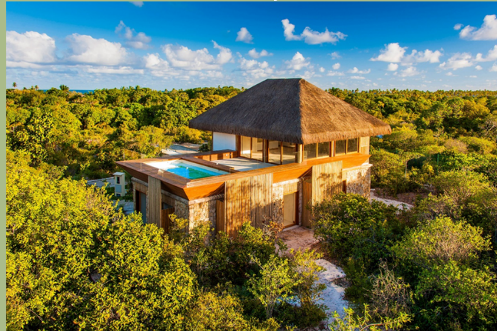
19: Vista da instalação individual.
