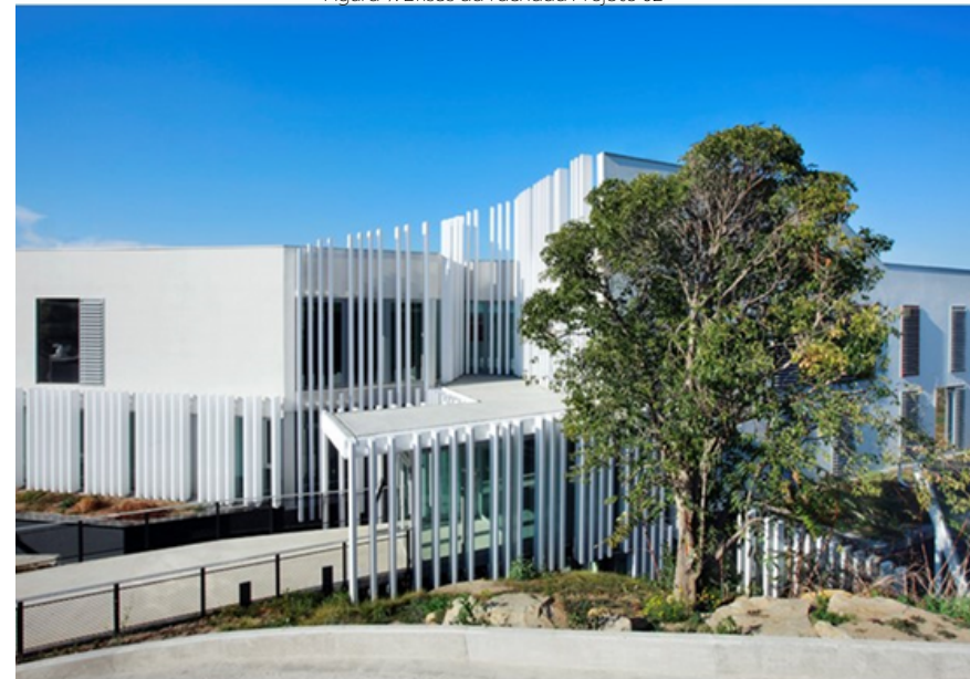
Figura 9. Brises da fachada Projeto 02
