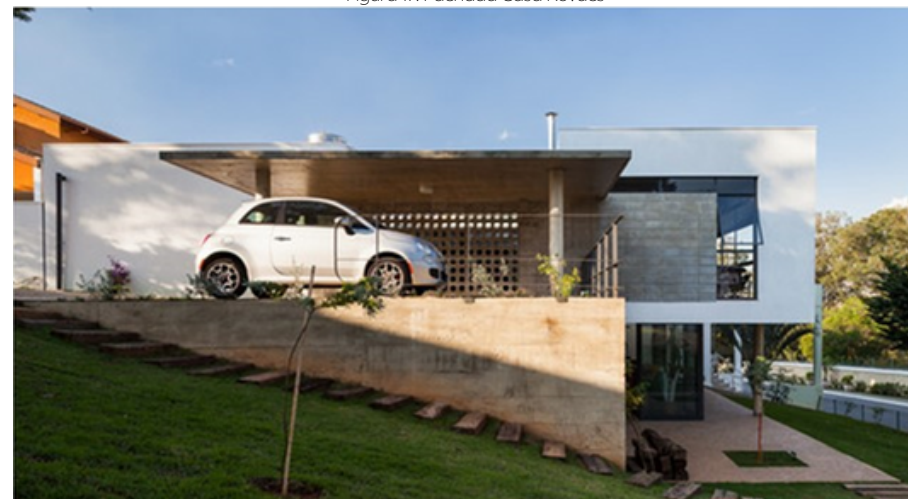
Figura 17: Fachada Casa Kovacs
