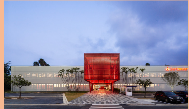
Figura 34: Fachada Geração Digital Santander
