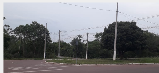
Figura 48: Poste de Iluminação Av. Des. Milton Figueiredo
