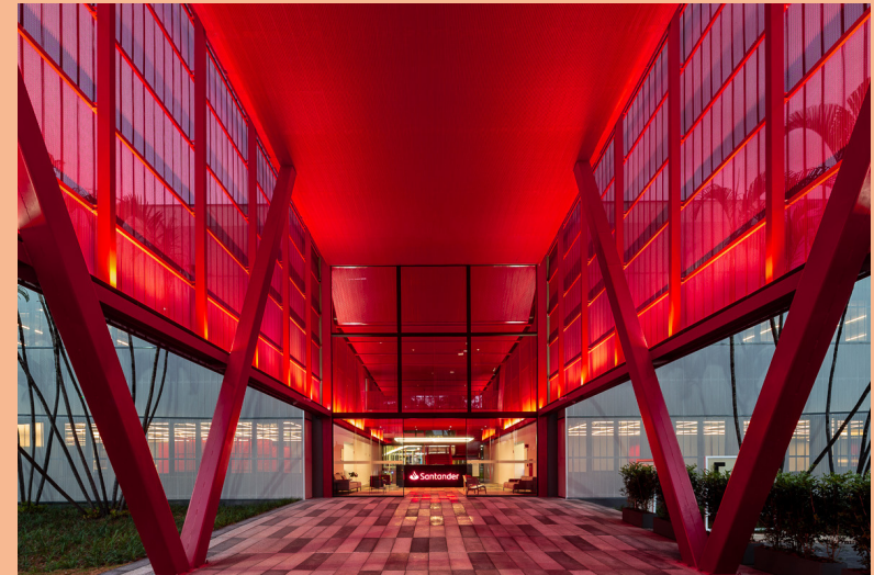
Figura 35: Fachada Geração Digital Santander
