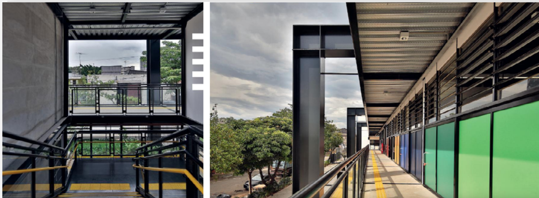
Figura 7: Estrutura metálica predominante no edifício
