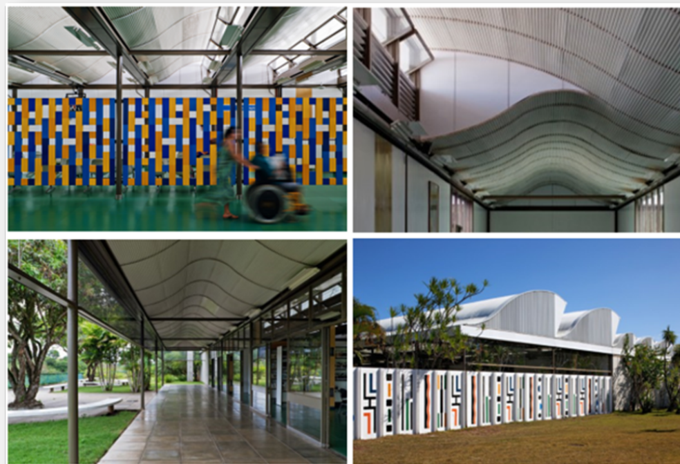
Figura 3: Cobertura com shed metálico curvo e painéis multicoloridos
