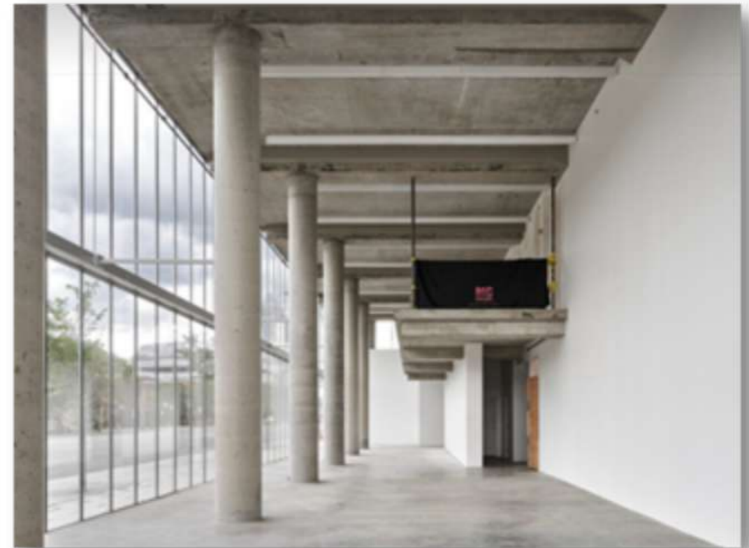
Figura 16 – Vista interna do Edifício Corporativo The Edge
