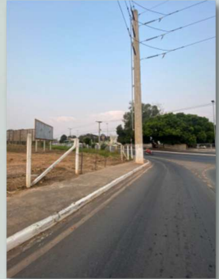
Figura 41 – Fachada Rua Onze de Maio
