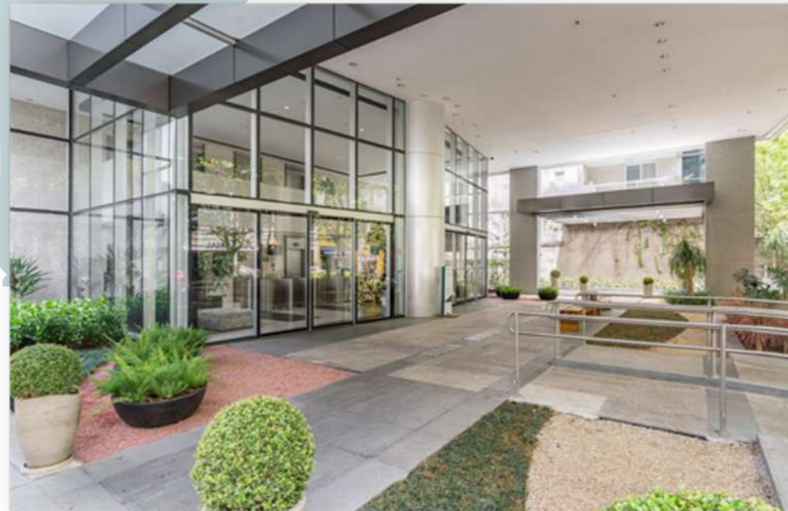
Figura 24 – Entrada do Edifício
