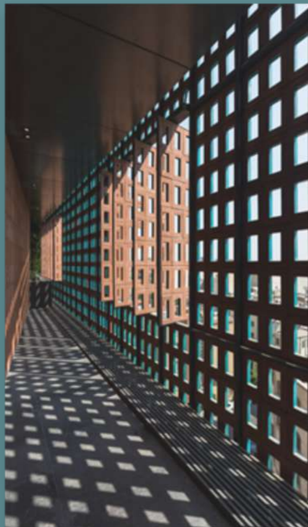
Figura 7 – Imagem Interna do painel
