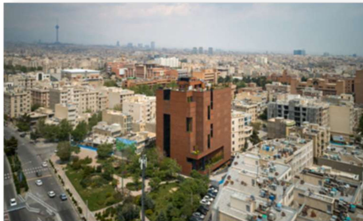
Figura 5 – Imagem do Edifício Corporativo Sharif
