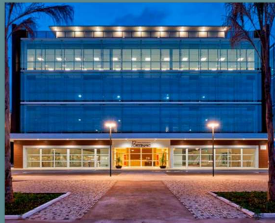
Figura 32 – Entrada Centro Corporativo Portinari
