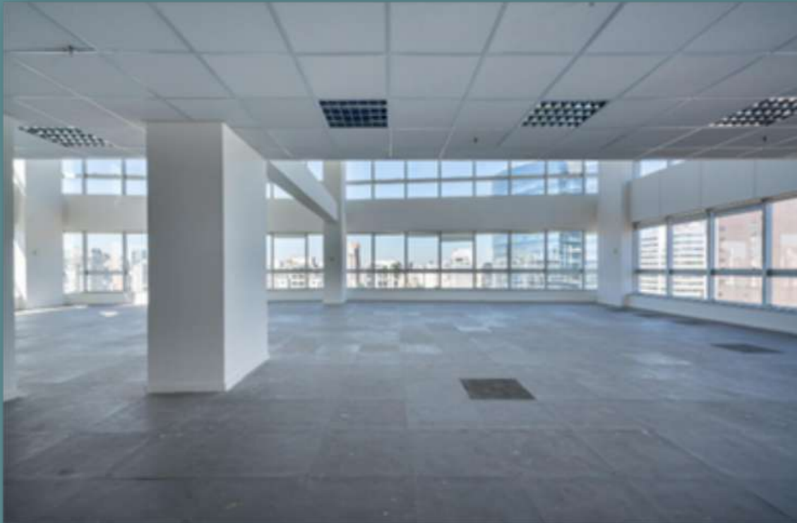
Figura 28 – Cobertura do Edifício
