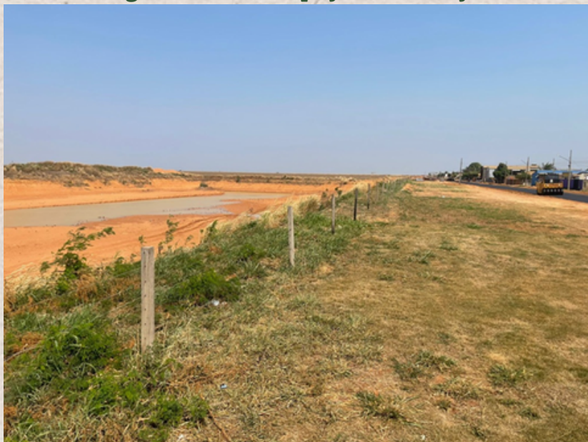
Figura 60: Vista do poço de infiltração
