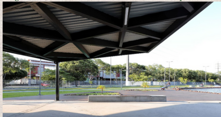
Figura 26: Telhado estrutural de metal do Parque Futuro
