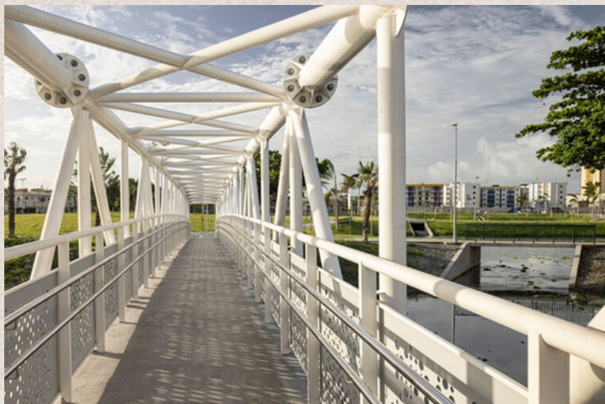
Figura 17: Passarela metálica do Parque Rachel de Queiroz
