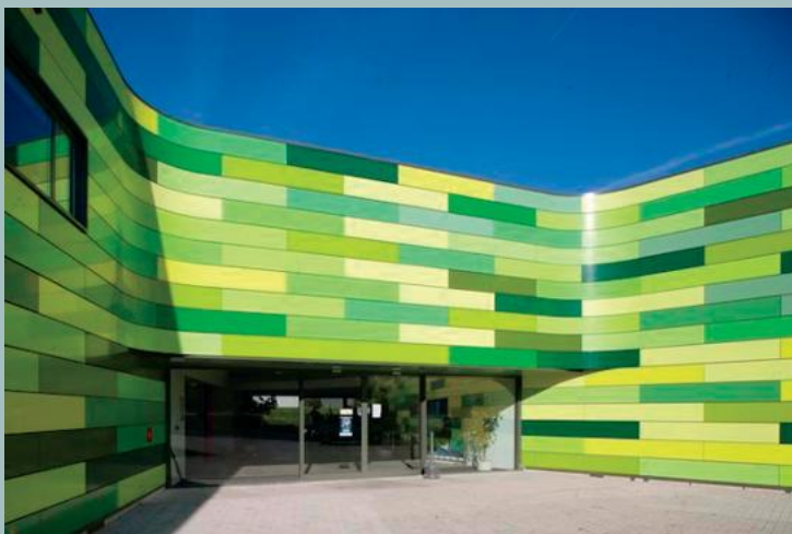
25 – Vista da fachada principal
