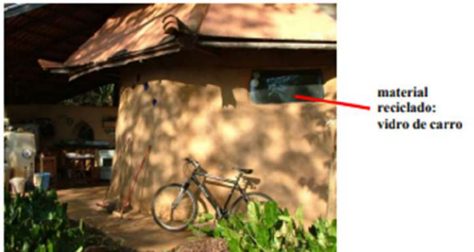
Figura 34: Construção em taipa
