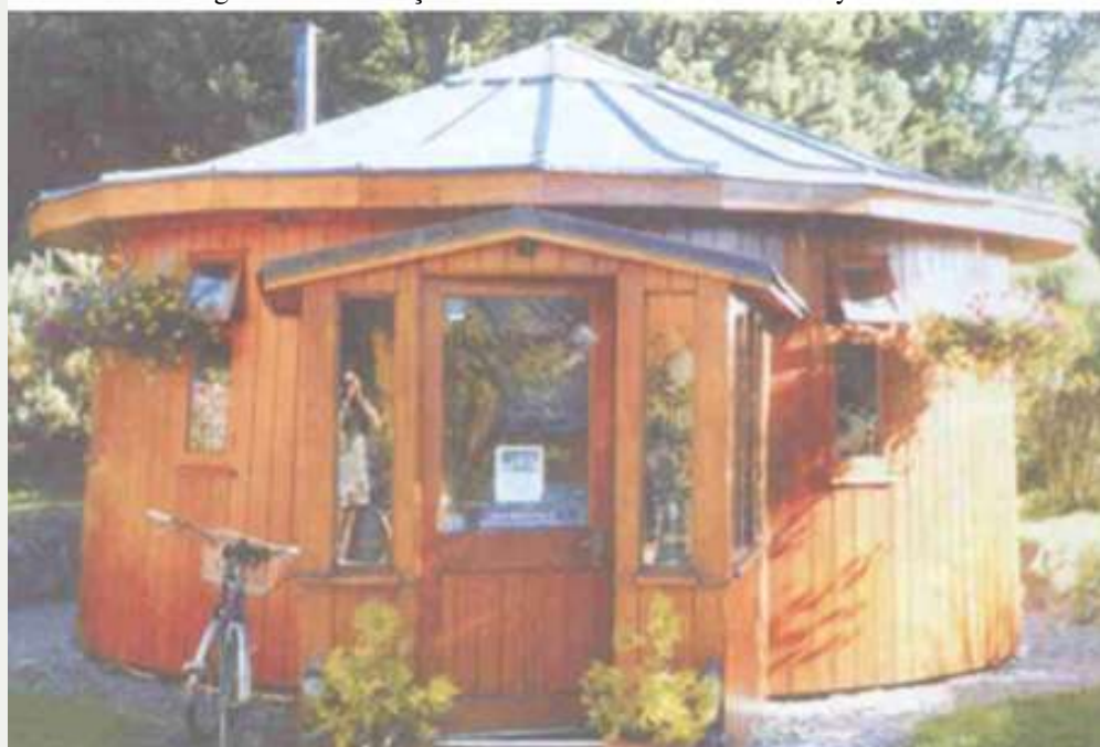
Figura 19: Construção com madeira de barris de whisky
