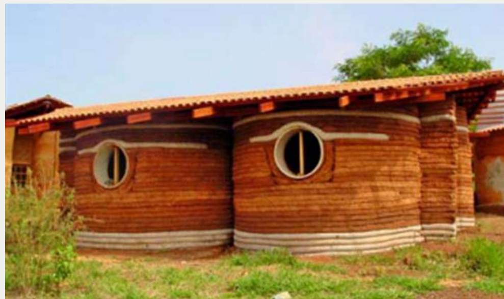
Figura 33: Construção superadobe
