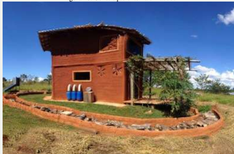
Figura 46: Construção externa em adobe
