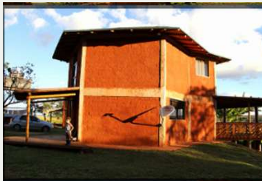
Figura 47: Construção externa em adobe
