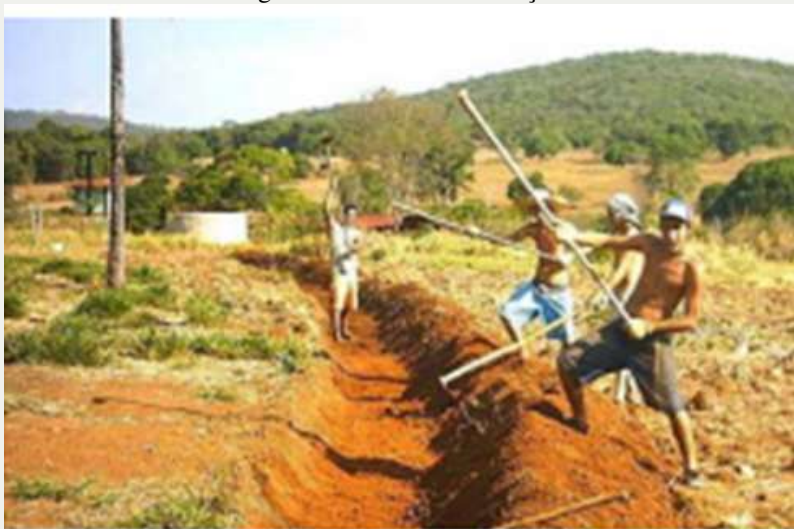
Figura 41: Canal de infiltração
