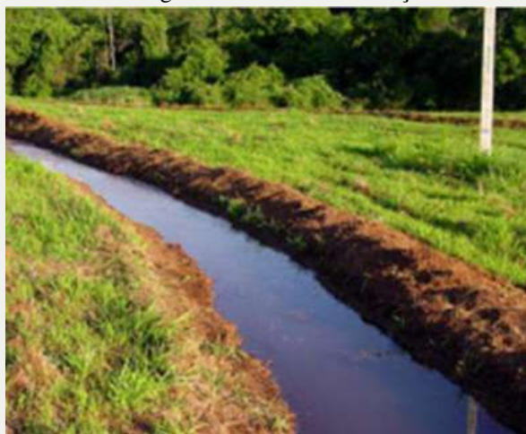
Figura 42: Canal de infiltração
