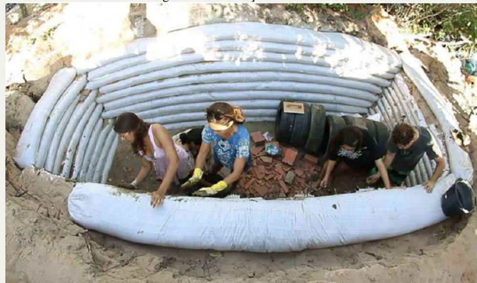
Figura 53: Construção sistema BET
