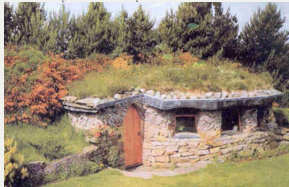
Figura 18: Santuário em pedras locais e telhado verde
