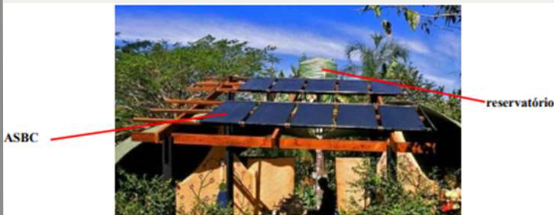
Figura 38: Esquema de ASBC e reservatório
