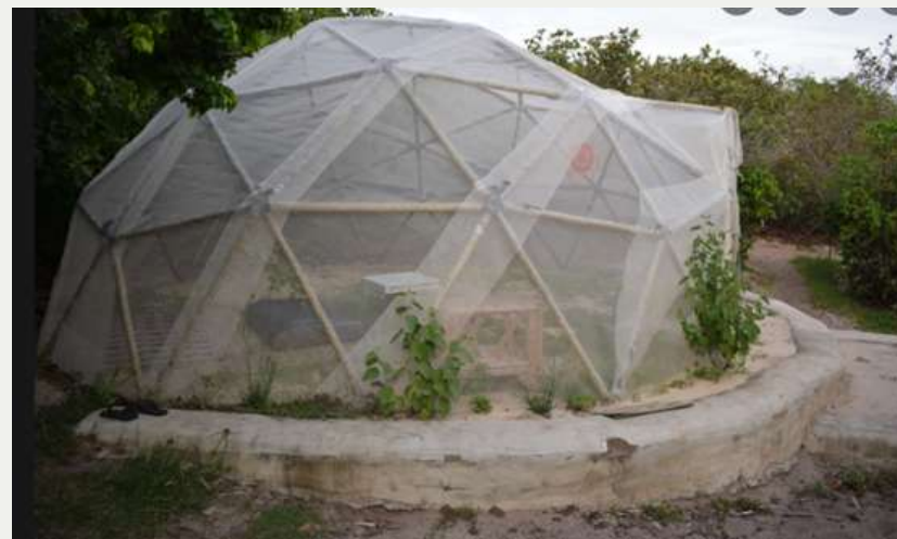
Figura 57: Cobertura em tela de algodão cru
