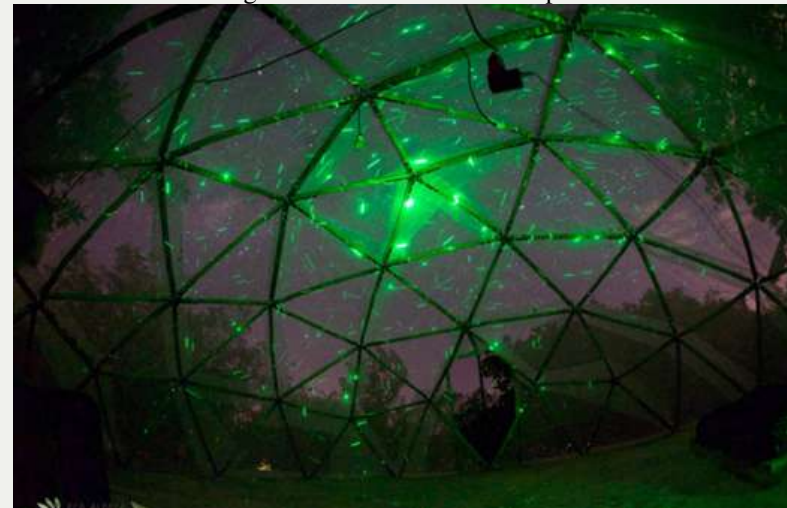
Figura 56: Estrutura em eucalipto
