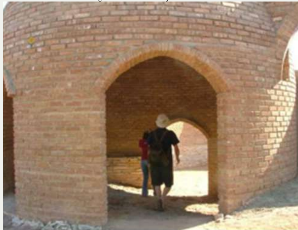
Figura 31: Anfiteatro tijolos de adobe
