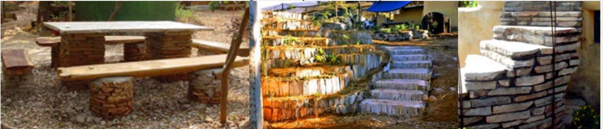
Figura 36: Uso de pedras locais na construção
