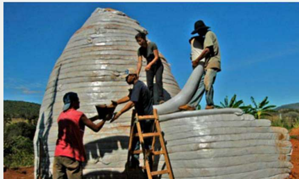
Figura 32: Construção superadobe
