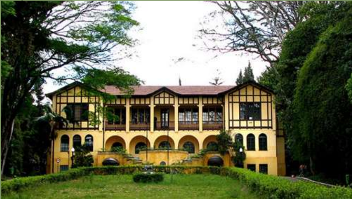
Figura 10: Infraestrutura do Parque Água Branca, em São Paulo
