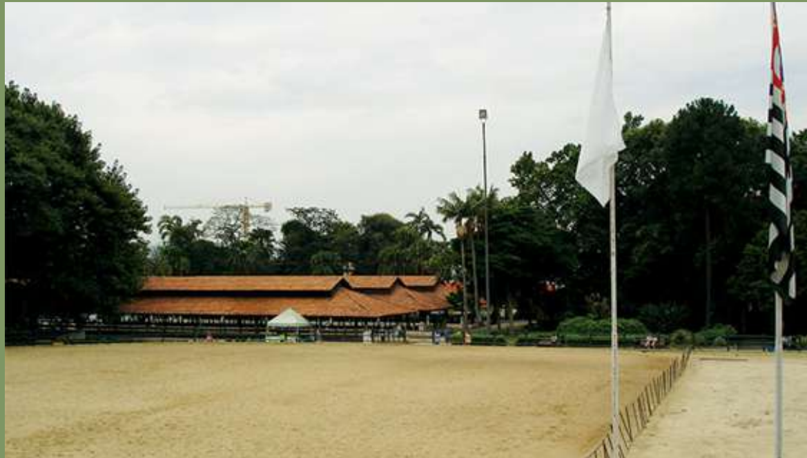
Figura 9: Infraestrutura do Parque Água Branca, em São Paulo
