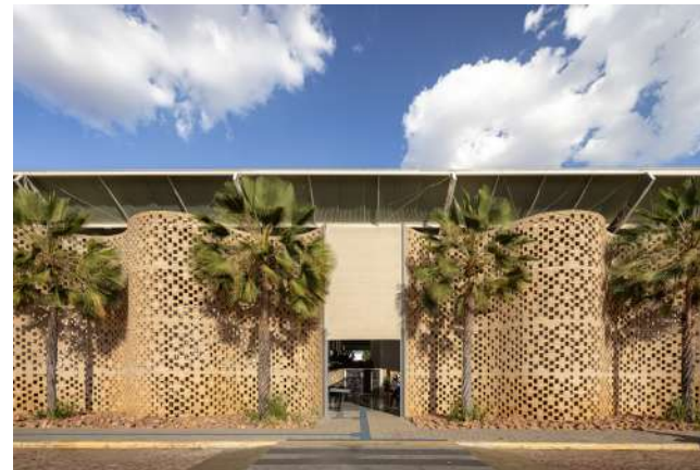
Figura 16: Fachada do Hospital Veterinário Escola da Unileão.
