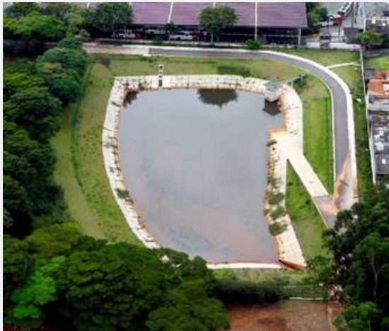
Figura 112: Bacia de detenção
