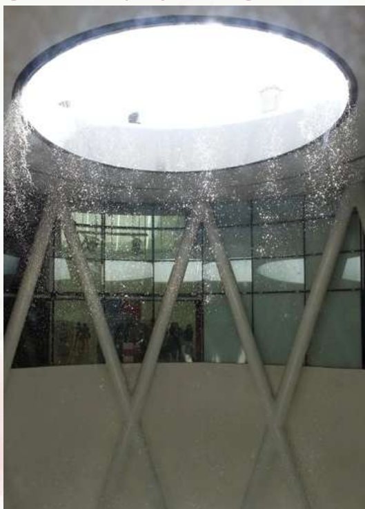
Figura 12. Captação da água da chuva
