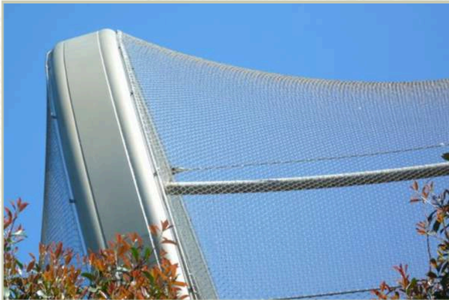
Figura 18: Rede de Contenção.
