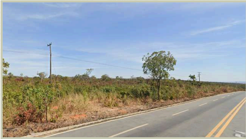
Figura 28: Postes de iluminação Rodovia Emanuel Pinheiro.
